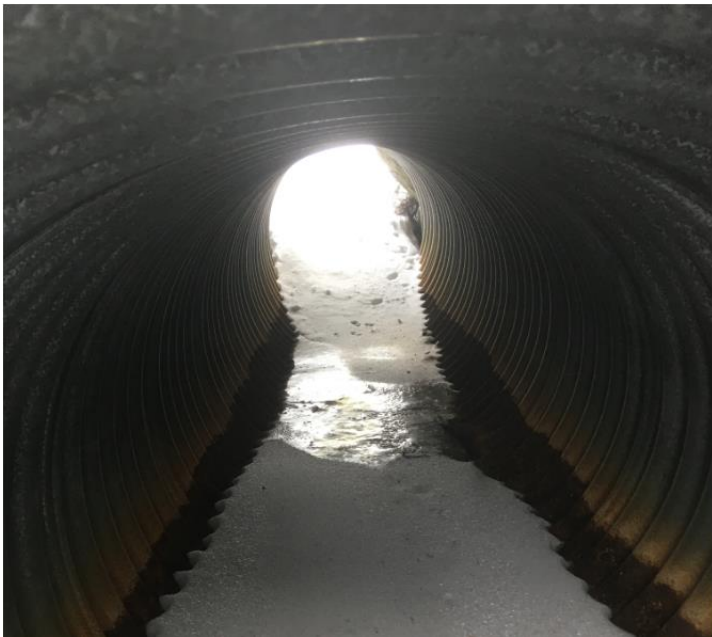
Figur 3-3: Bilde av kulvert 1 sett fra nedstrøms side.
