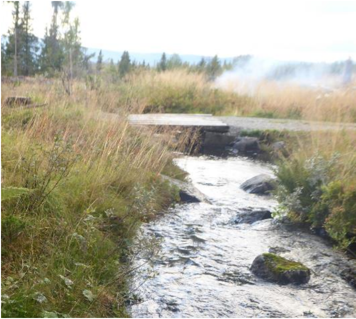
Figur 3-2: Bilde av bro sett fra oppstrøms side.
