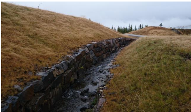
Plastret bekkeløp for Søre Slåbekken
