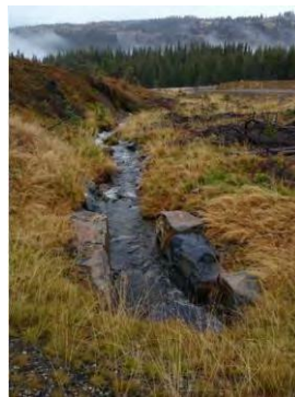
Utløp til opprinnelig bekkeløp nedstrøms
