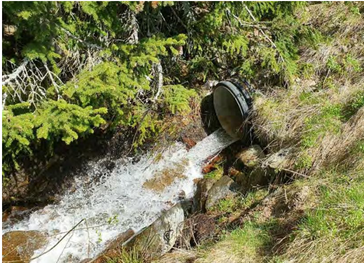
Utløp til Lysa fra bekkelukking
