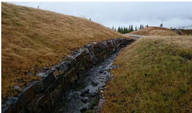
Plastret bekkeløp for Søre Slåbekken
