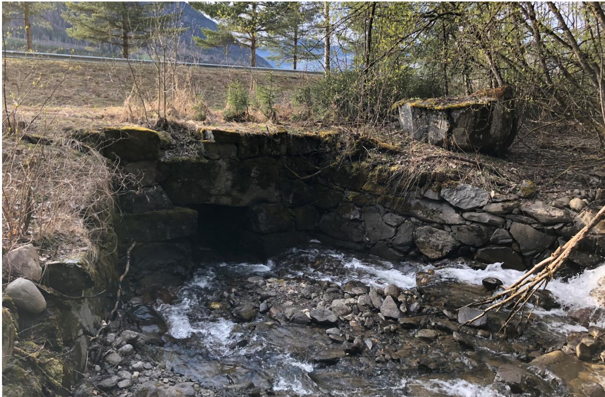
Figur 19 Stikkrenne ved fv.2522 i Merradalen. Foto: Asplan Viak
