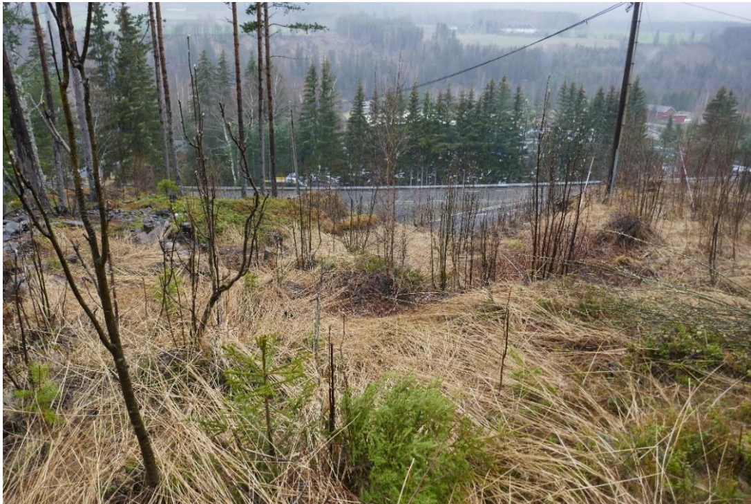
Figur 12 Bilde av flomløp ned mot krysset Hundervegen/Sørbygdsvegen (Foto: Asplan Viak).
