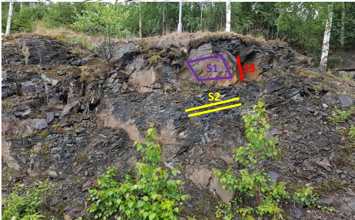
Figur 19: Bergskjæring i profil 3470 – 3490.
