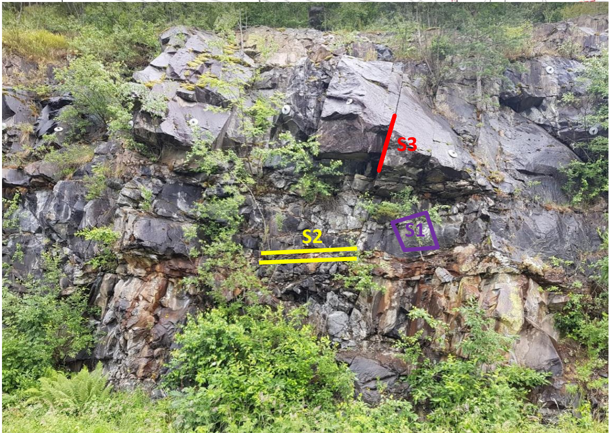
Figur 21: Bergskjæring i profil 4180 – 4460.
