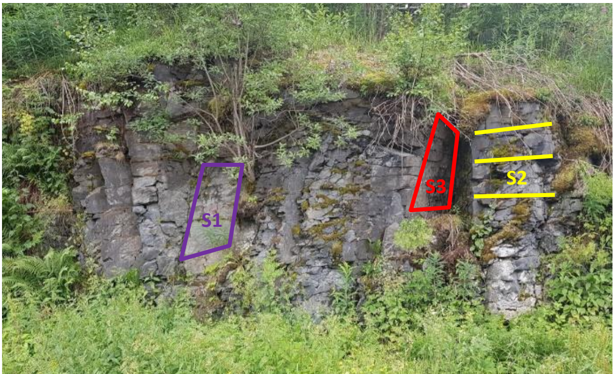
Figur 15: Bergskjæring i profil 815 – 850.
