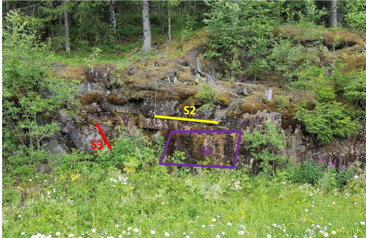
Figur 17: Bergskjæring i profil 2540 – 2620.
