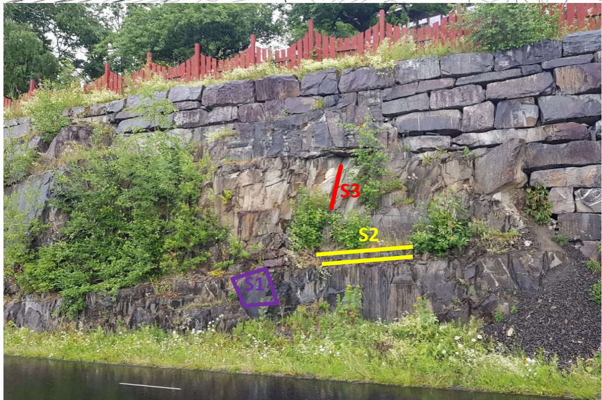
Figur 20: Bergskjæring i profil 3490 – 3680.
