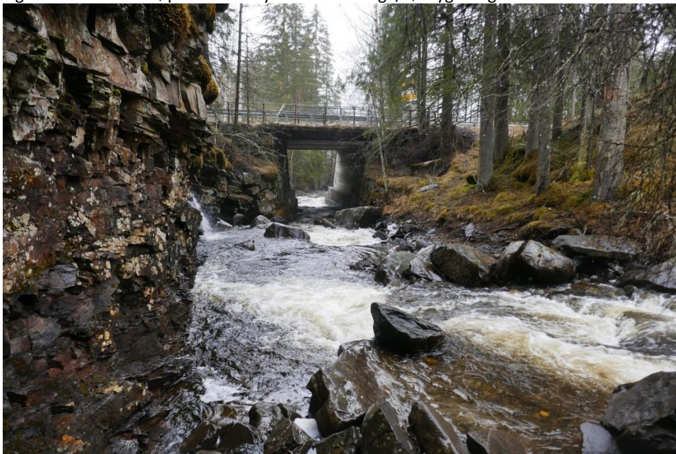
Figur 10 Bilde som viser lysopning under bro og høydeforskjell opp til eksisterende bro.
