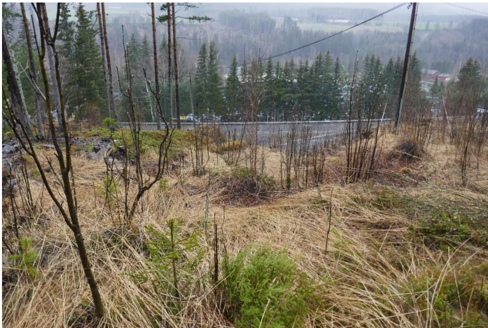
Figur 9 Bilde av flomløp ned mot krysset Hundervege/Sørbygdsvegen.
