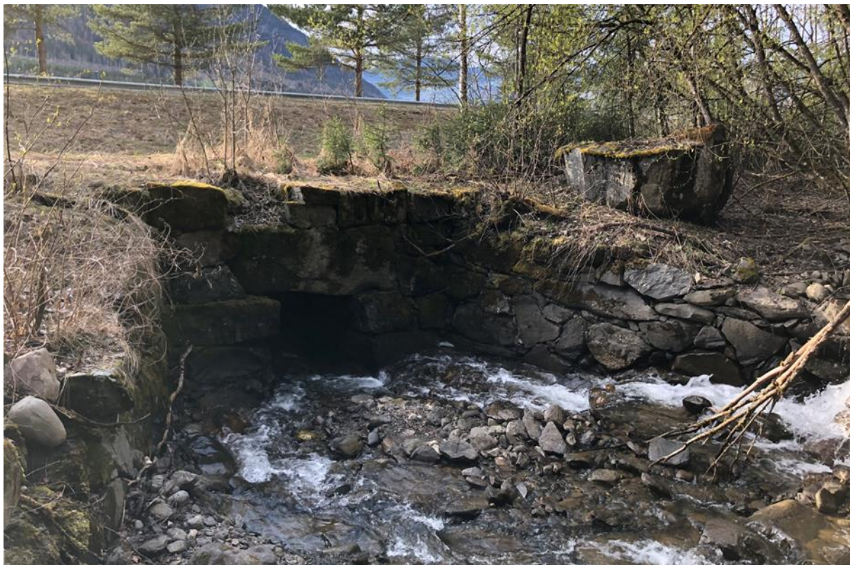
Bilde 2-1 Innløp steinkulvert (foto: Asplan Viak)
