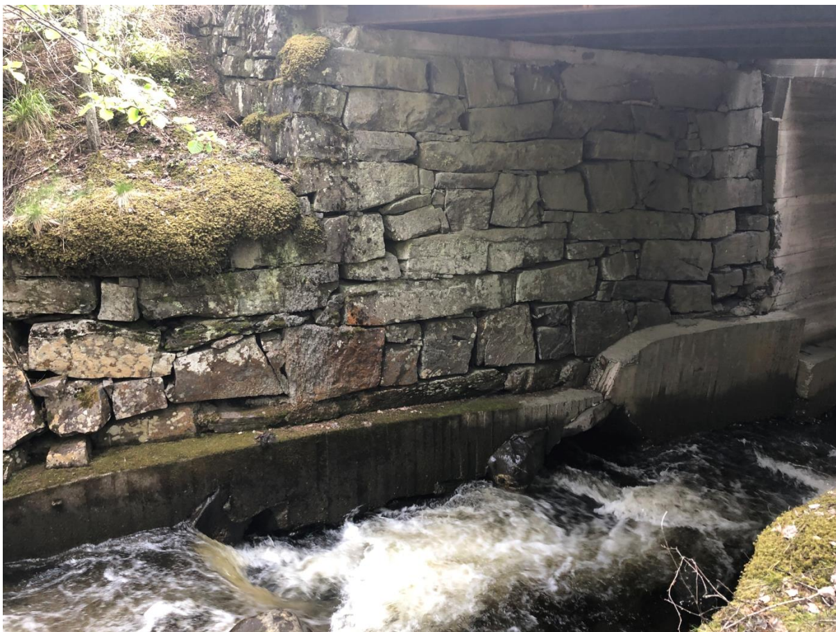
Figur 2-8. Midtskog bru med detalj av sørlig brukar på den gamle brua. Foto: Innlandet fylkeskommune.
