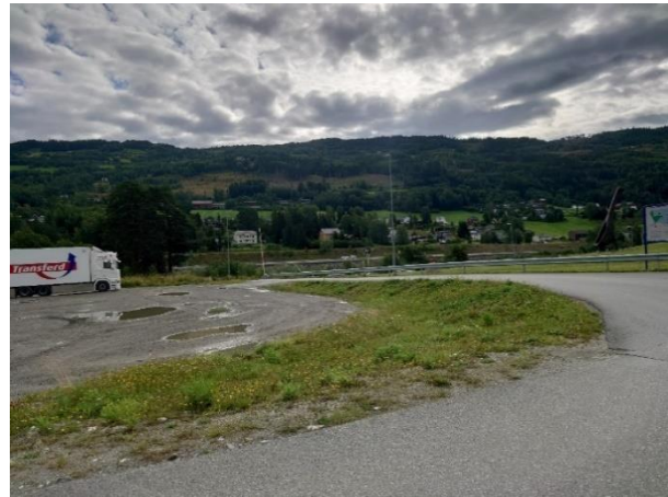
Figur 25: Adkomstveg fra fylkesvegen inn på planområdet ses i venstre figur. Her vil flomvann fra undergangen under jernbanen strømme over og til parkeringsareal ut til venstre. Parkeringsareal ses i figuren til høyre.
