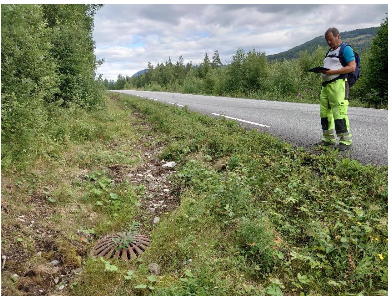
Figur 17: Flertallet av stikkrenner gjennom fylkesvegen er anlagt med inntakskum med kuppelrist - ingen forhøyning på nedstrøms side. Spor etter antatt graving av fiberkabel i gøftetraseen/ved kummen.
