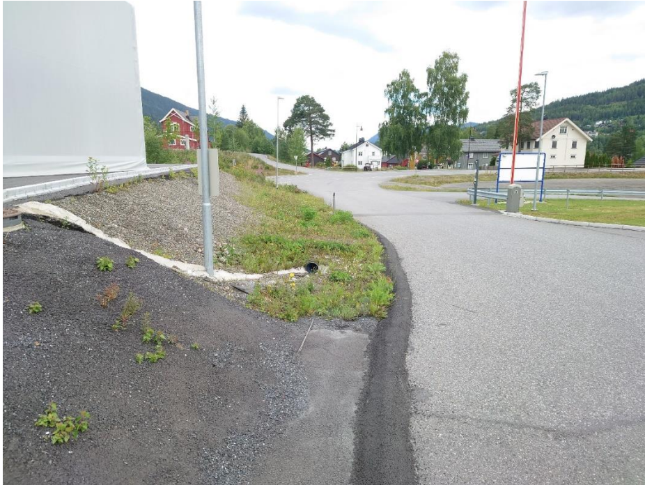
Figur 31: Løsning med opphøyd asfaltkant for å lede overflatevann. Her fra østre side av plasthall sett mot nord. Ved plasthallen til venstre i figuren skimtes midlertidig kantstein som leder vannet til ei nedføringsrenne og deretter ned i ei kort stikkrenne som har utløp noen få meter mot nord.
