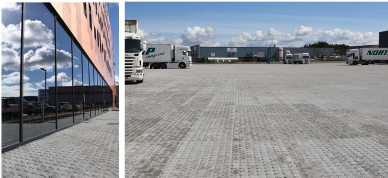
Figur 39: Venstre bilde: eksempel fra Hotel Pond, Stavanger (Skjeveland.no). Til høyre: Nortemp sitt lageranlegg på Bryne – 14000 m2 med permeabel belegning.
