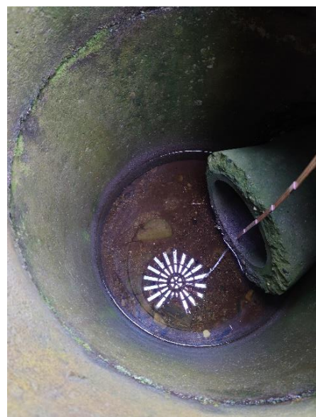
Figur 17: Flertallet av stikkrenner gjennom fylkesvegen er anlagt med inntakskum med kuppelrist - ingen forhøyning på nedstrøms side. Spor etter antatt graving av fiberkabel i gøftetraseen/ved kummen.
