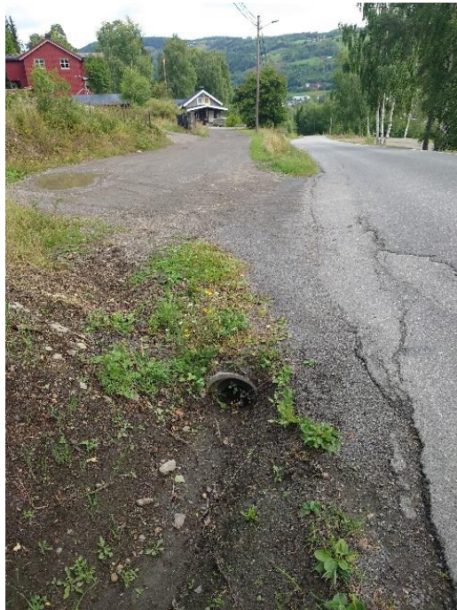
Figur 13: Øverste bilder viser inntak bekkelukking ved Vassrud (nordre). Til venstre: bilde tatt fra nedstrøms side av inntaket som består av antatt plass-støpt betongløsning og enkel stålrister. Til høyre: bilde av betongrør i inntaket, antatt ca. 400 mm. Nederste bilde viser enkel, grunn stikkrenne under adkomstveg til boliger på motsatt side av fylkesvegen for Vassrud (nordre). Stikkrennen leder vann fra veggrøfta rett oppstrøms bekkelukkingen inn på bekkelukkingen som videre ligger i grøfteareal nedover langs Musdalsvegen (midt i bildet).
