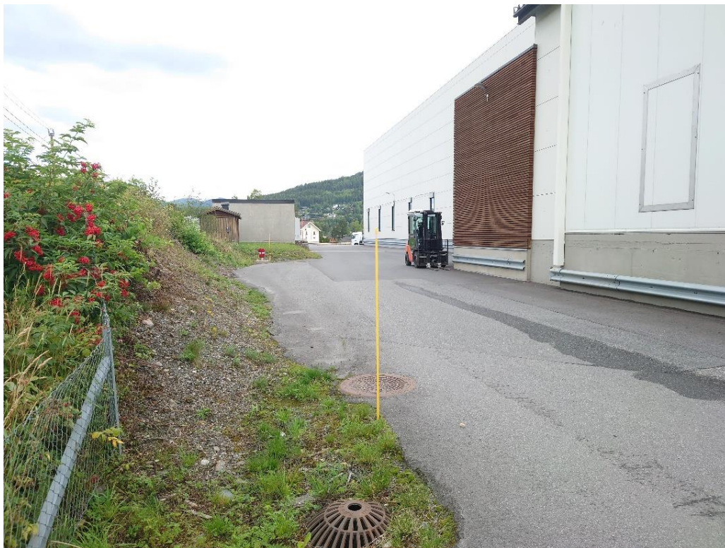
Figur 29: Bilde av sluk vest av hovedbygningen ved TINE Meierietretten - bilde tatt i retning nord.
