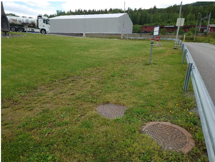
Figur 32: Fra plenarealer nord på området hvor det tidligere har vært pukkfylt grøft. Bilde tatt i retning vest. Plasthall ses i bakgrunnen.
