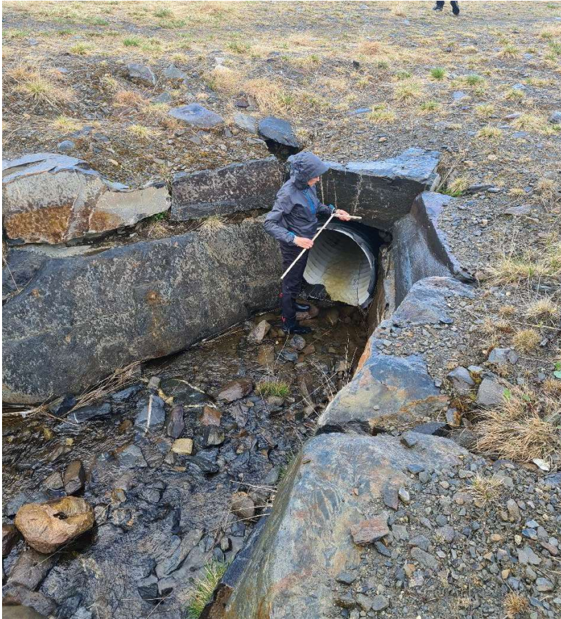
Figur 4-9: Typisk kulvertinnløp, her vist i Søre Slåbekken oppstrøms skiløypa over Kronrøysa.
