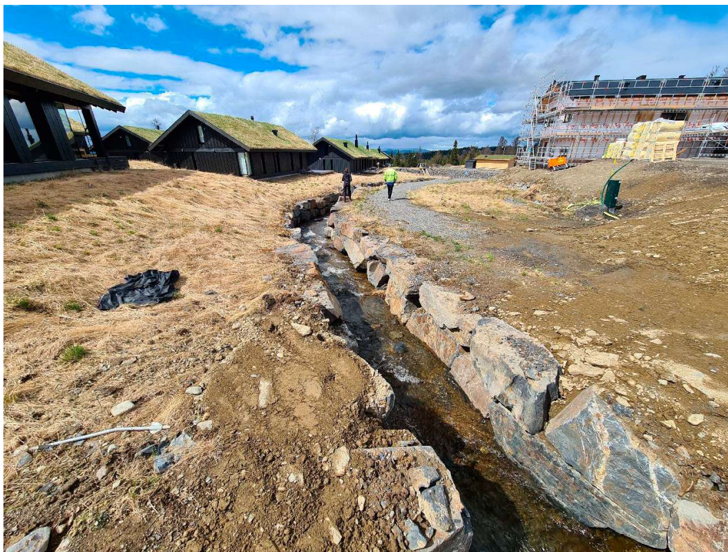
Figur 4-2: Bekkeløp i Nørdre Slåbekken, oppstrøms FLS3
