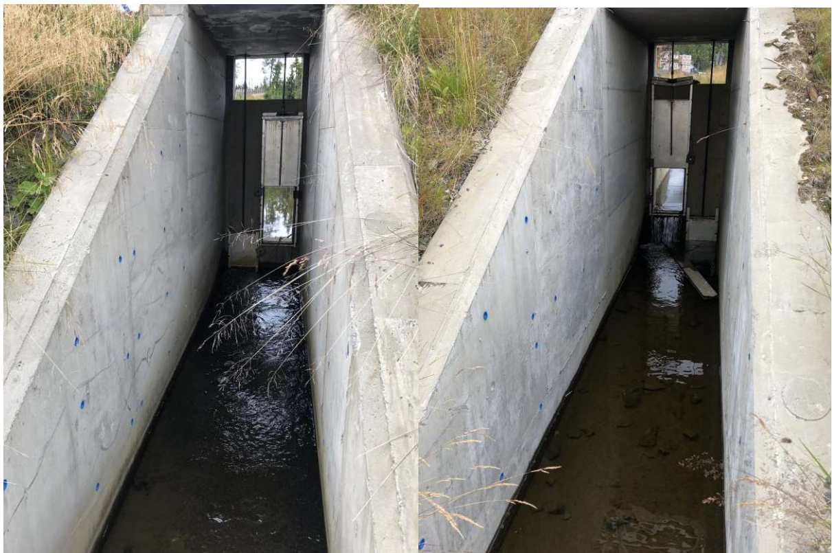
Figur 5-7 Utløpskonstruksjonen ved FLS3 (venstre) og FLS4 (høyre), Nørdre Slåbekken.
