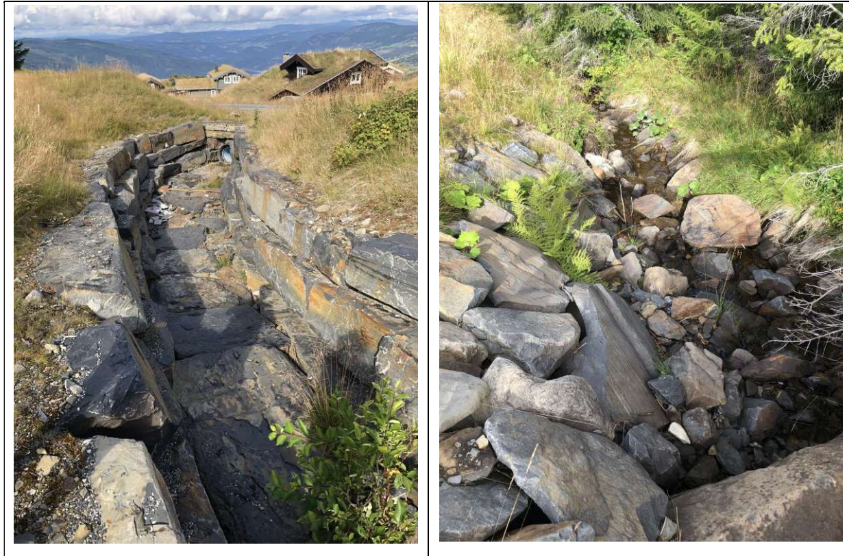
Figur 3-3: Nedstrøms dam FLS1; plastret kanal (venstre), utløp Skurgrasbekken, (høyre).
