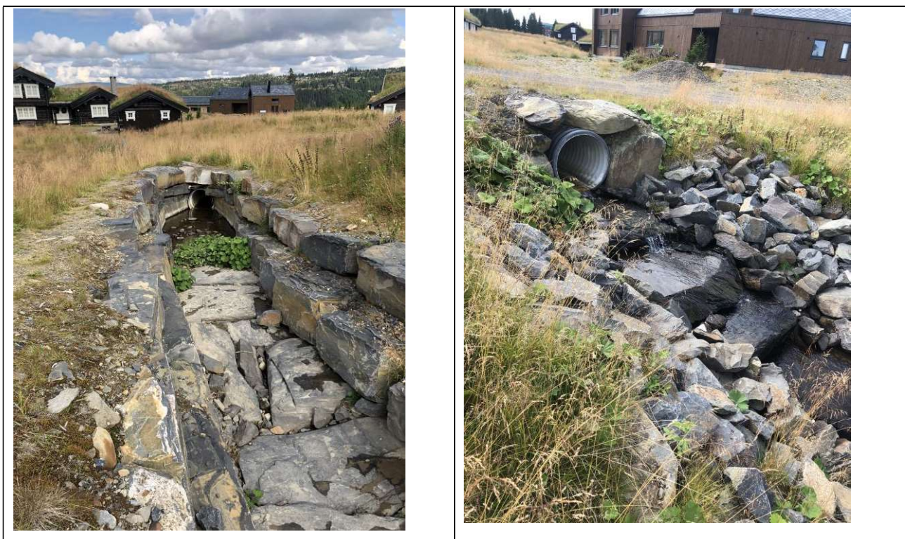
Figur 3-4: Felt B, plastret kanal til fordrøyning (venstre), kryssing under vei/løype (høyre).
