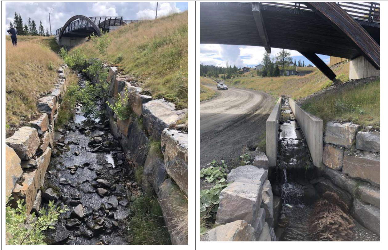
Figur 3-5: Plastret kanal (venstre), støpt kanal langs Mosæterveien under bru (høyre).
