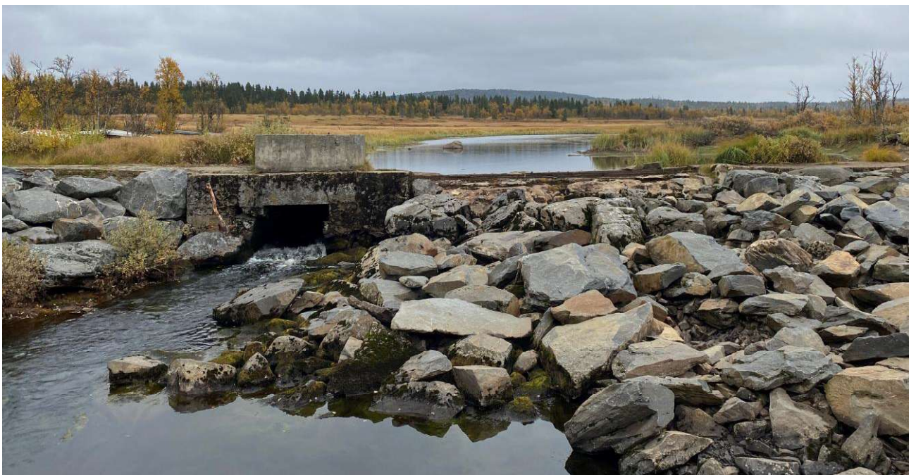
Figur 7-2 Dam Moksjøen sett fra nedstrøms side. Foto: Multiconsult
