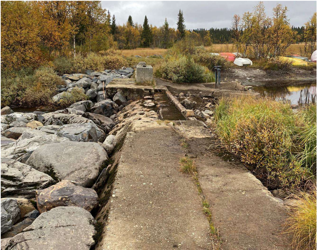
Figur 7-1 Dam Nedre Moksjøen. Foto: Multiconsult
