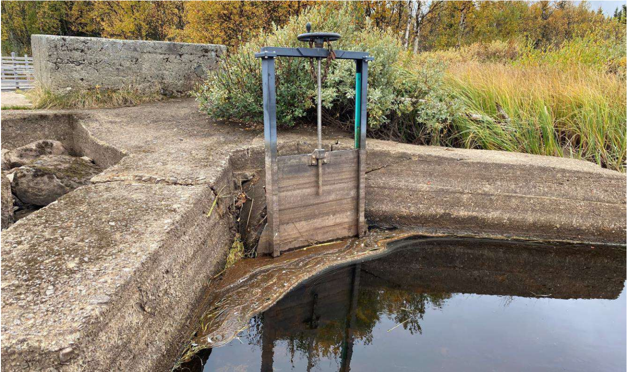
Figur 7-3 Tappeløpet ved dam Nedre Moksjøen (sett fra oppstrøms side). Foto: Multiconsult
