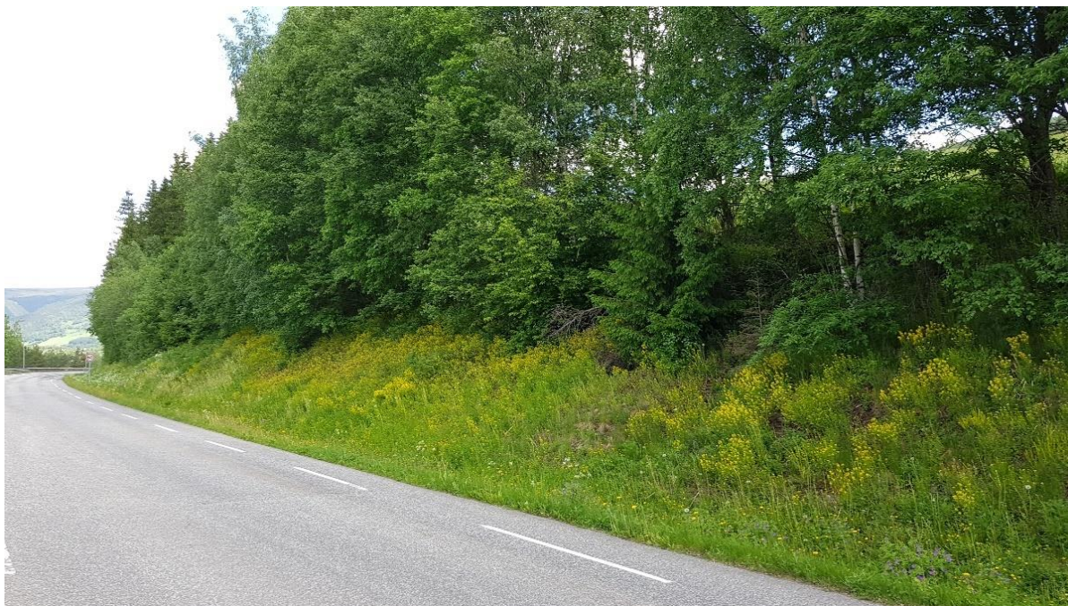
Figur 5-12 Jordskråning mellom Fossegården og Merradalen. Foto: Asplan Viak.
