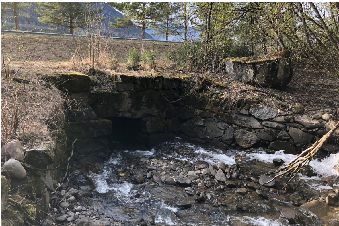
Figur 3-6 Stikkrenne/kulvert under fv. 2522 i Merradalen. Foto: Asplan Viak
