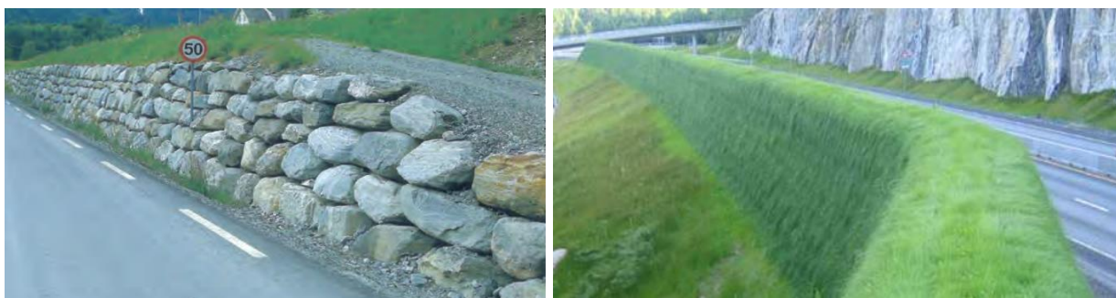
Figur 5-30: Venstre: Eksempel på tørrmur (fra SVV håndbok 182 publisert i 1995). Høyre: Eksempel på torvblokker (fra hallingtorv.no).
