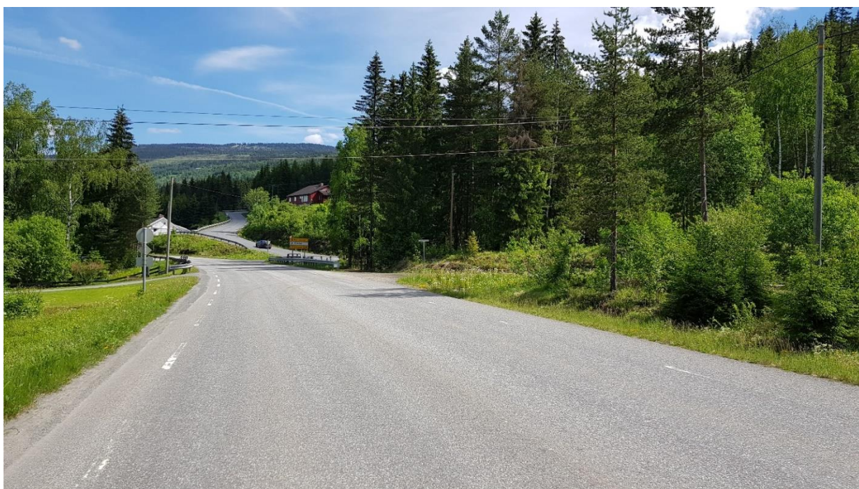
Figur 3-4: Fv. 2522 sør for Sagåa, perspektiv mot nord og kryss med Sørbygdsvegen. Foto: Google.
