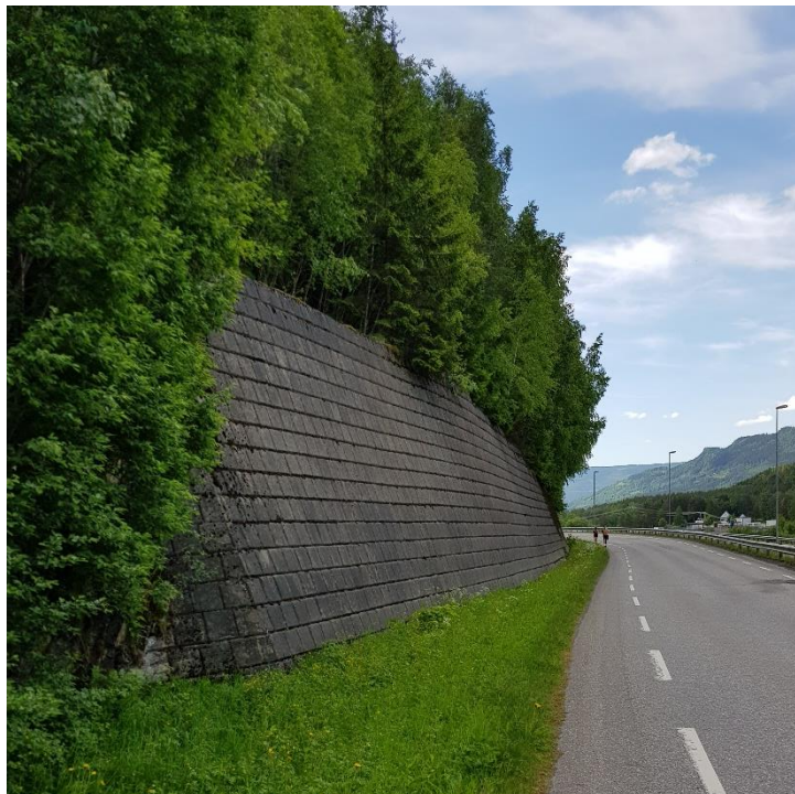
Figur 5-16 Eksisterende betongblokkmur sør for Merradalen. Foto: Asplan Viak.
