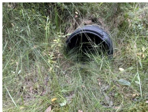
FIGUR 11 STIKKRENNE (250 MM) UNDER RUNDMYRVEGEN
