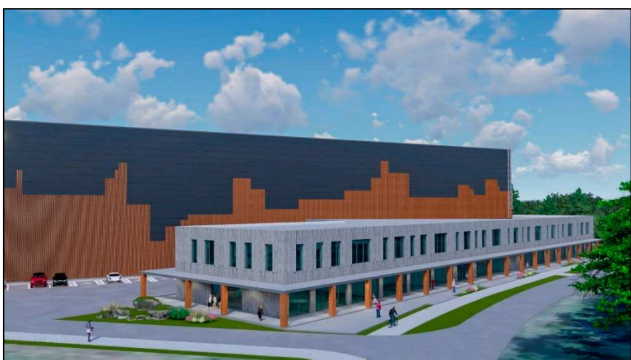
Figur 19: To etasjers nærings- og kontorbygg
