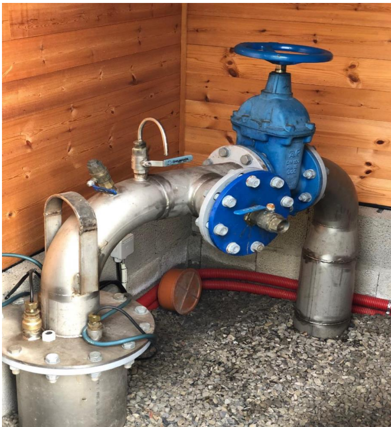
Figur 6-6 - Eksempel på røropplegg i et brønnhus
