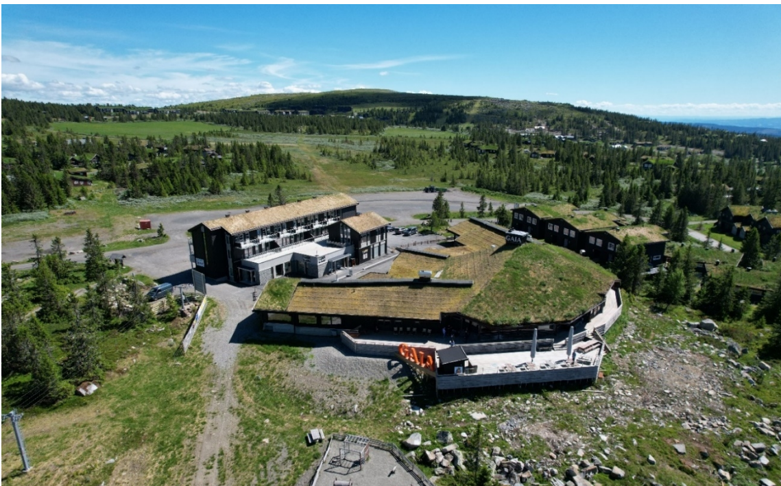
Flyfoto som viser at storparten av planområdet allerede er opparbeidet i dag. Lunnstadmyra ligger i bakkant av eksisterende p-plass.
