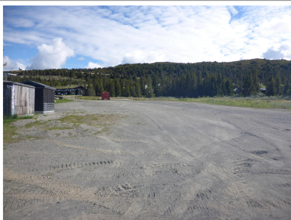
Bilde 1: Parkeringsplassen ved Gaiastova, dekket med fyllmasser, sand, grus.
