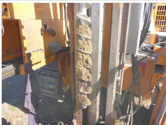
Bilde 3: Masser fra Prøvepunkt 1 – typiske fyllmasser, sand/grus i øverste lag på parkeringsplassen, og jord/torv lenger ned mot berget.
