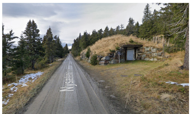
Figur 16: Nysetervegen høydebasseng (kilde: google street view)
