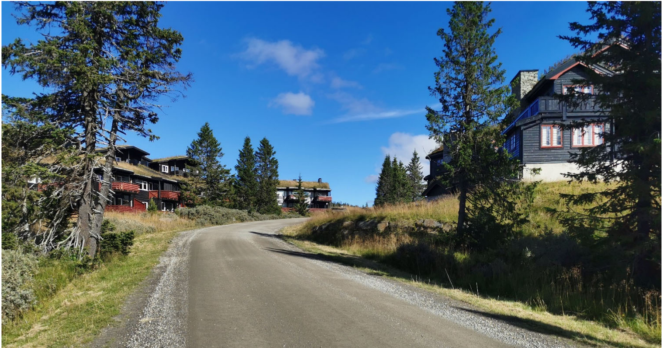
Figur 2: Et typisk utsnitt av Lunnstadmyrvegen sett i retning Gaiastova, med krapp kurvatur og antatt lavt fartsnivå
