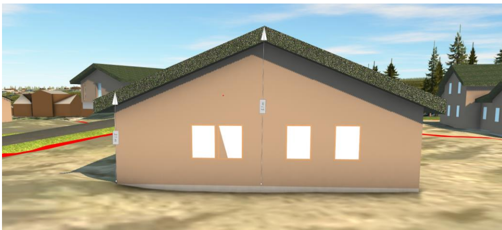
Figur 13: Eksempel på fritidsbolig i en etasje. Eksempelbygningene har mønehøyde på 5,1m og gesims på 3,1m
