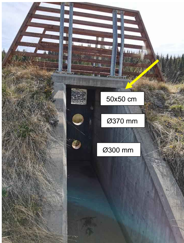
Figur 73: Utløp fra FLS1 (t.v.) og innløp av stikkrenne i punkt A (t.h.).
