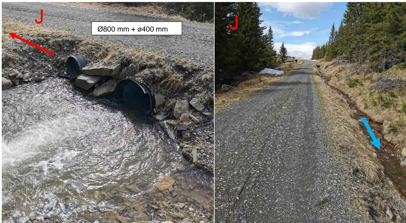
Figur 91: Innløp av stikkrenner i punkt J, som er kritisk ift. eventuell videre drenering mot Kleivbekken. Fra nord kommer det inn et sideløp av bekken via vegggrøfta langs Doldaveien (t.h.). Ved kapasitetsproblemer i punkt G kan vegggrøfta og punkt J få tilført vann fra Lysa nord, spesielt i en flomsituasjon.
