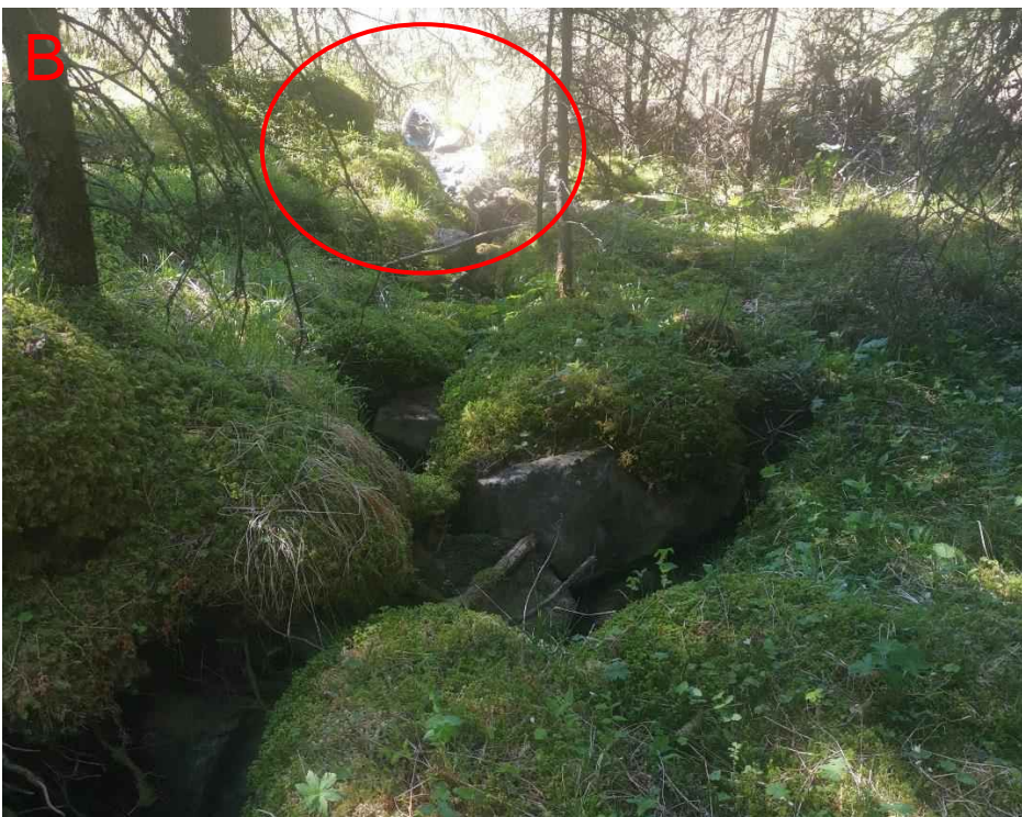
Figur 158: Stikkrenna (350 mm) gjennom Doldaveien i punkt B. Det er dessverre ikke bedre bilder av dette punktet. Her kan vann ta på avveie sørover og inn i Stubberudbekken dersom stikkrenna går full eller tettes.
