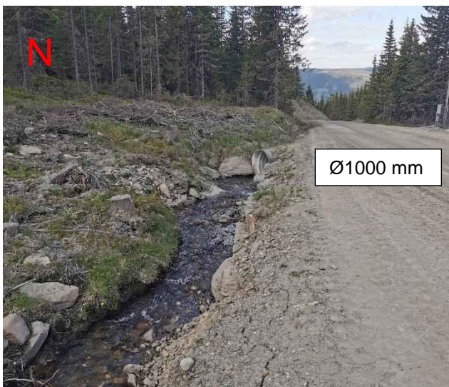
Figur 69: Til venstre er innløpet av stikkrenne i punkt N, som ved kapasitetsproblemer vil medføre at vannet renner nedover langs Mosætervegen. Der har ikke veggrøfta god kapasitet, og det vil kunne bli en del/mye utvasking. Det er også tegn på erosjon i vegkanten oppstrøms stikkrenna, trolig pga. utvidelse av vegen. Det er fylt løsmasser helt ut/ned i bekken. Til høyre vises bekkeløpet til Dalanbekken i oppstrøms ende av strekning O. Lenger ned er bekkeløpet erosjonssikret/kanalisert på en liten strekning. Potensialet for erosjon og massetransport er stort ettersom bekkeløpet er av løsmasser og ligger mellom løsmassefyllinger.
