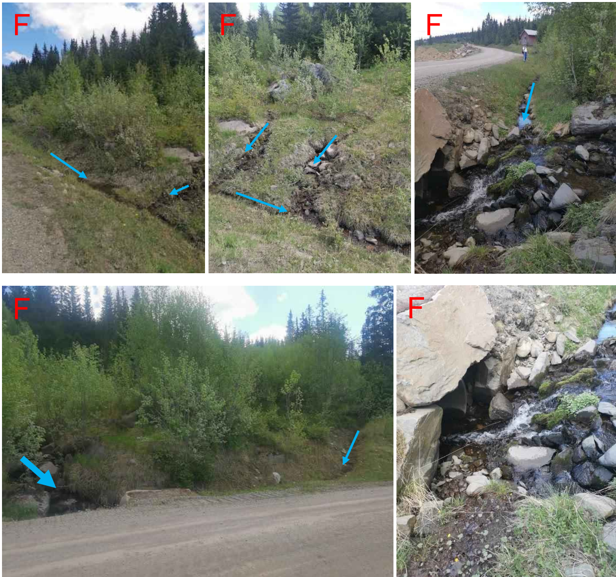
Figur 189: Bildene viser alle vannveiene som kommer inn i Stubberudbekken ved Storsteinvegen, disse er vist med blå piler. Hovedløpet til Stubberudbekken er markert med en tykkere blå pil i bildet nederst til venstre. Bildene til høyre er av innløpet på stikkrenna (1000 mm) i punkt F gjennom Storsteinvegen. Dersom denne går tett eller full, kan vann ta ukontrollert på avveie inn i det nye planområdet Bjørgesætra. Dette punktet skal derfor oppgraderes til å håndtere flomvannføringer i Stubberudbekken.
