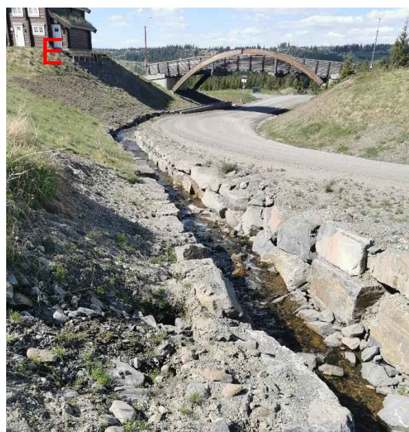
Figur 50: Vann har gravd ut løsmasser mellom større steiner (se gule piler) som er brukt til kanalisering av bekken. Det kan f.eks. komme av mangelfull utførelse av kanalisering, høyere strømningshastighet enn det kanalen er dimensjonert for, og tidvis stor avrenning fra den langsgående vegen og sideområder. Bildet til høyre viser at bekken har lite plass å boltre seg på ved kapasitetsproblemer i kanalen.
