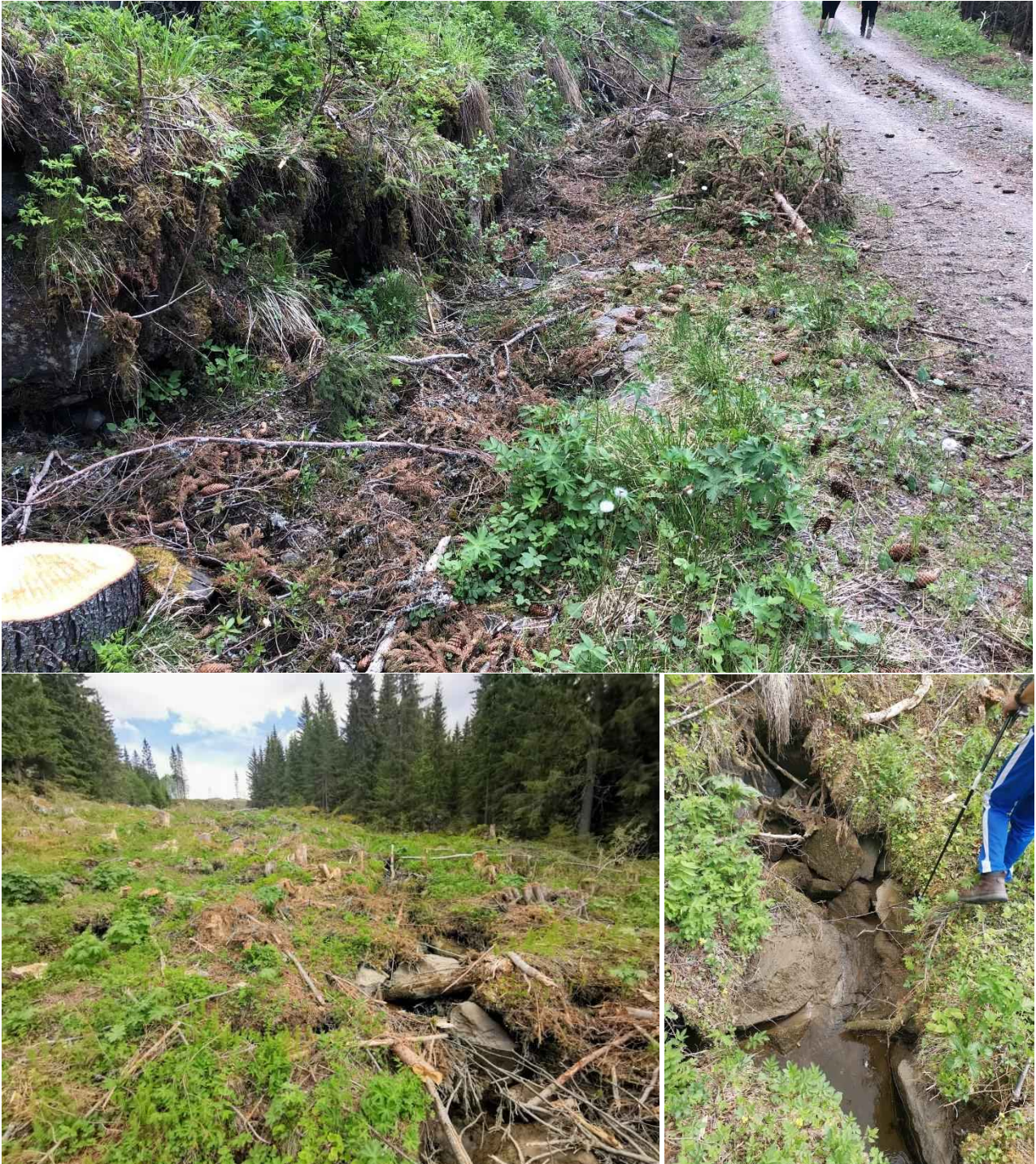
Figur 223: Bildet øverst viser veggroften langs Doldaveien hvor et det lagt masse hogstavfall. Bildet nede til venstre er tatt fra Doldaveien, og viser hvor Bjørgebekken skulle gått. Som en følge av planlagt utbygging med manglende hensyn til bekken og snauhogst har den blitt rasert og spredt, samt at finstoffer er ført med bekken og avsatt i bekkeløpet som vist i bildet nede til høyre.
