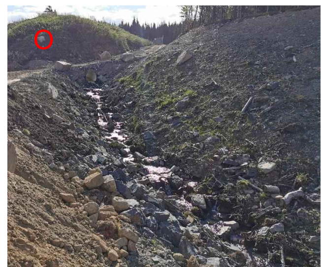
Figur 69: Til venstre er innløpet av stikkrenne i punkt N, som ved kapasitetsproblemer vil medføre at vannet renner nedover langs Mosætervegen. Der har ikke veggrøfta god kapasitet, og det vil kunne bli en del/mye utvasking. Det er også tegn på erosjon i vegkanten oppstrøms stikkrenna, trolig pga. utvidelse av vegen. Det er fylt løsmasser helt ut/ned i bekken. Til høyre vises bekkeløpet til Dalanbekken i oppstrøms ende av strekning O. Lenger ned er bekkeløpet erosjonssikret/kanalisert på en liten strekning. Potensialet for erosjon og massetransport er stort ettersom bekkeløpet er av løsmasser og ligger mellom løsmassefyllinger.
