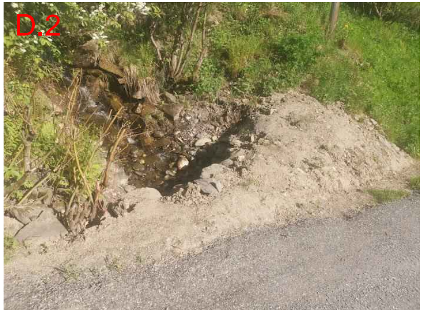
Figur 165: Bildene viser strekket ned til og innløpet til stikkrenna (600 mm) som tar Solbergbekken under adkomstvegen til Sørbygdsvegen 332. Det er laget en voll rundt innløpet. Her er det stor fare for erosjon, gjentetting av innløp og vann på avveie.
