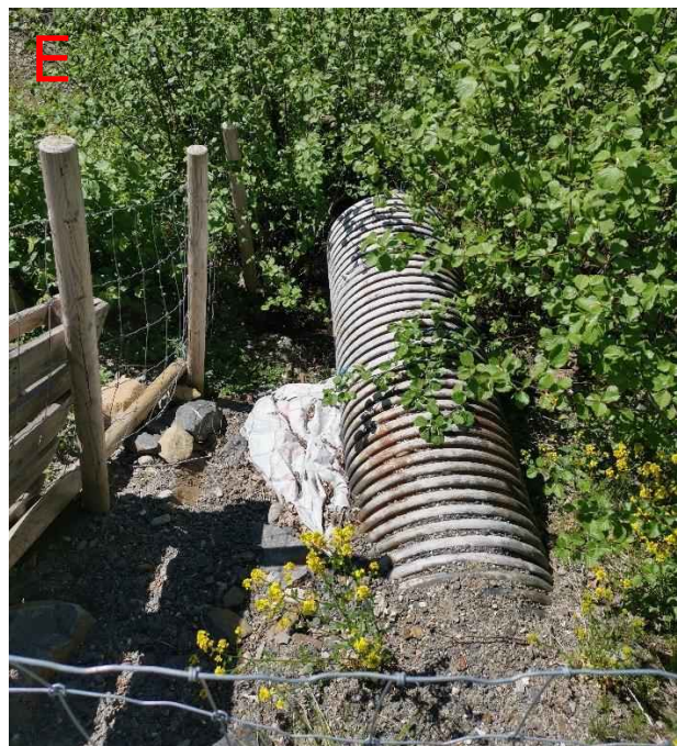
Figur 137: Inn- og utløpet til stikkrenna (550 mm) i punkt E ved Lykkja. Dersom denne stikkrenna tettes eller går full kan vann ta på avveie mot Råbøl, Kaldhol og annen bebyggelse. Det var mye hogstavfall nedstrøms denne stikkrenna.
