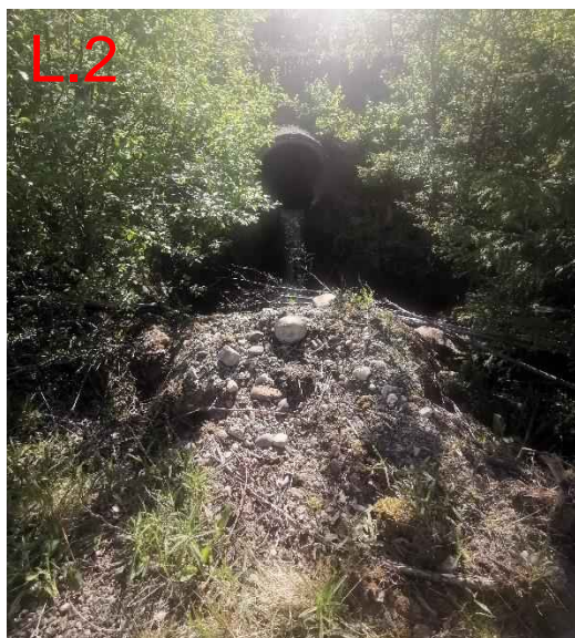
Figur 205: Bildet til venstre er hentet fra Google Street View (tatt oktober 2019) og viser «overgangen» mellom stikkrenne L.2 (1000 mm) og L.3 (1000 mm, erosjonsskadet). Bildet til høyre viser utløpet til stikkrenne L.2.
