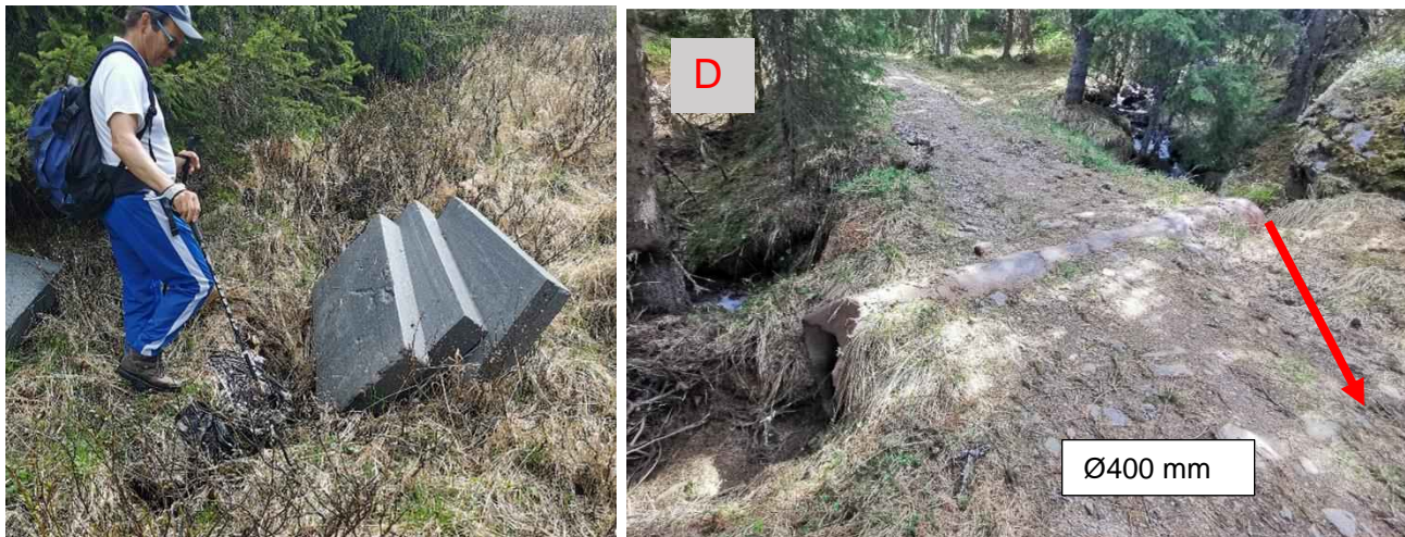
Figur 62: Til venstre ses isolasjonsmateriale og plastsøppel i myra oppstrøms Mosætra, et godt stykke fra bebyggelsen. Trolig er dette kommet med vinden. Til høyre: Sårbart punkt D på Dalanbekken, hvor det har vært mye erosjon og massetransport. Det er to stikkrenner, ei nyere og et gammelt jernrør DN400 som er sammenklemt. Vann på avveie kan medføre fare for bygninger
