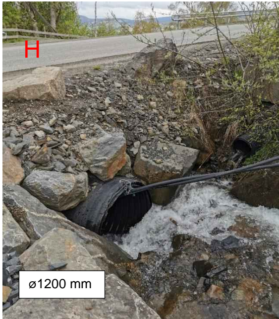
Figur 122: Punkt H - Kulvertinnløpet er sårbart for gjentetting, både mtp. massene som er/kan avsettes og kablene som er ført gjennom. Flomvei fra innløpet er i veggrøfta ti IMosætervegen (høyre bilde), hvor det er tegn til at det kan ha vært problemer tidligere. Avhengig av kapasiteten til veggrøfta kan vann også renne over vege og ned mot byginger på nedsiden av vege.
