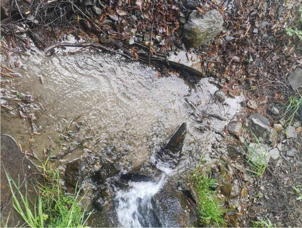
Figur 228: Bildet viser innløpet til stikkrenna som fører et sideløp av Bjørgebekken gjennom Sørbygdsvegen ved Haverlykkja, hvor det er laget en grøft på utsiden av vege mot Bjørgebekken. Vannet kommer ut av et rør i skråningen et lite stykke ovenfor eiendommene. Den er nesten gjentettet og ved flom vil vann isteden drenere nedover til Bjørgebekken på oversiden av vege.
