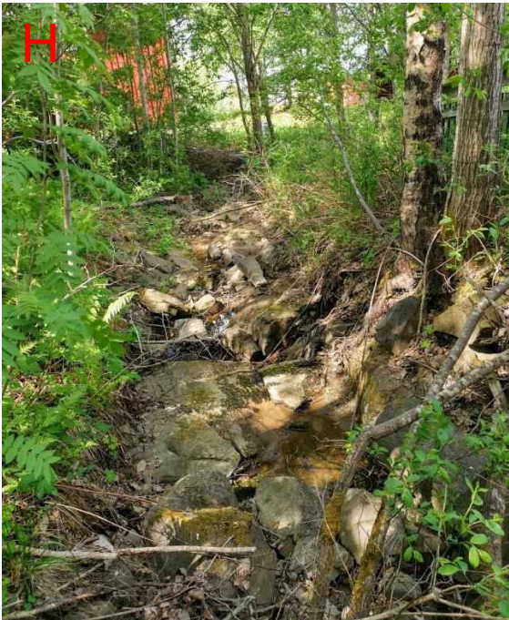
Figur 225: Bekkelukking ved Fjellstadvegen 9, hvor bekken er lagt i rør (800 mm) et stykke ved siden av eiendommen. Det er dog tydelige spor av at bekken har rent over lukkingen og vasket ut løsmassene over og rundt. Røret er delvis blottlagt. Tomten er fylt ut i bekken, og gjerdet er lagt over bekken. Det er mye erosjon på strekket, hvor massene kan bli ført med videre ned og tette stikkrenner nedstrøms. Øverst til venstre vises grøft på oversiden av eiendommene inn mot bekken fra nord.
