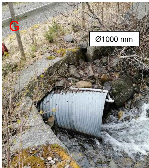
Figur 121: Punkt F (t.v.): Innløpet på stikkrenne ved Mosætervegen 165 sett oppstrøms fra. Stikkrenna er trolig for liten og det er mye erosjon og sedimenter/sedimenttransport oppstrøms som kan tette den igjen/ redusere kapasiteten. Det er også tegn til erosjonsskader ut av bekkeløpet. Det er fare for bygningene nedstrøms i begge tilfeller. Punkt G (t.h.): Innløp på stikkrenne som ved gjentetting/ redusere kapasiteten kan medføre flomfare for flere bygninger nedstrøms. Det er en del erosjonsskader rundt innløpet, og røret gjennom stikkrenna kan øke faren for gjentetting.
