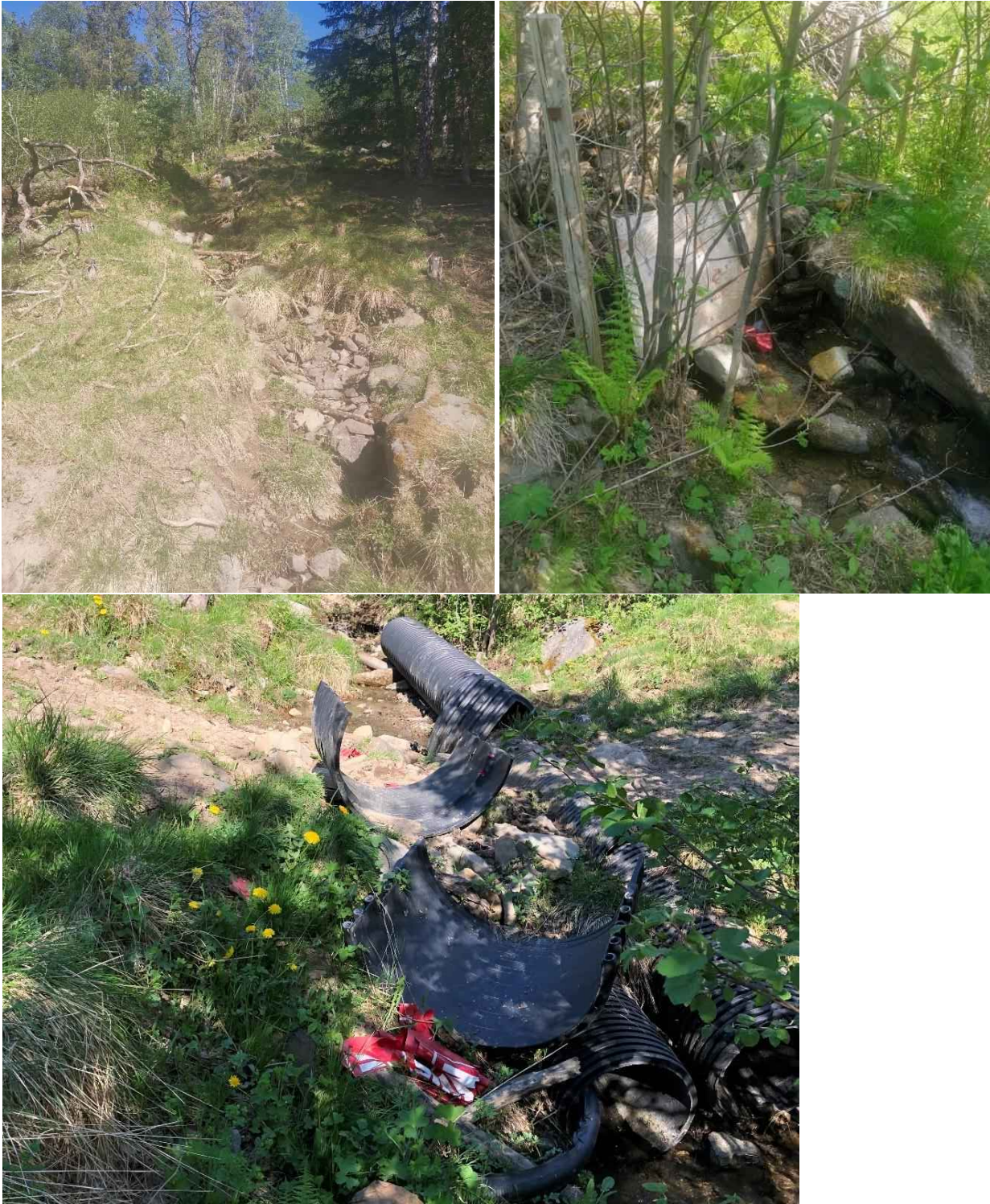
Figur 163: Bildet oppe til venstre viser flomløpet som vises med blå pil i Figur 162. Det er tydelig at det har gått en del vann her. Bildet oppe til høyre viser bekkeløpet like oppstrøms punkt D, hvor det er mye fremmedelemer i bekken, samt mye erosjon i bekkeløpet. Bildet nederst viser enda et eksempel på fremmedelemer og søppel i bekken, ødelagte stikkrenner og søppel i bekken.
