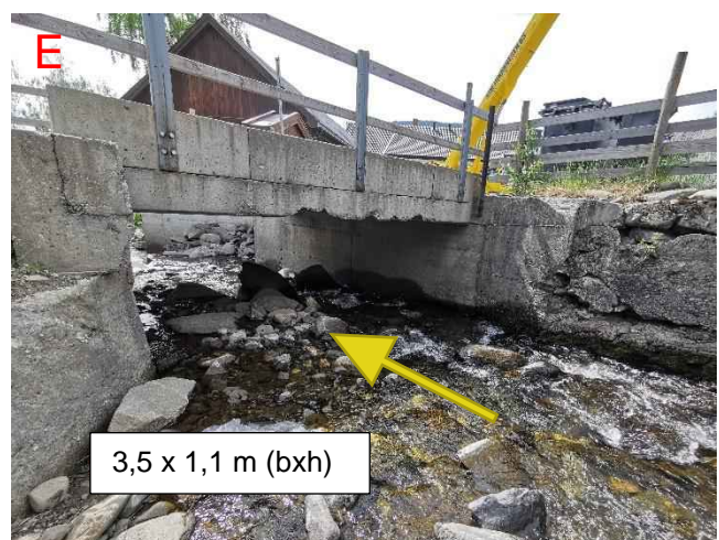
Figur 17: Bruer i punkt D (t.v.) og E. Bru D har bl.a. kabler/ledninger hengende foran og gjennom brua. Dette gir økt fare for at f.eks. trær og kvist setter seg fast og begrenser kapasitet i en flomsituasjon. Bilde av bru E viser spesielt høy fare for gjentetting, da flere store steiner blokkerer deler av lysåpningen.
