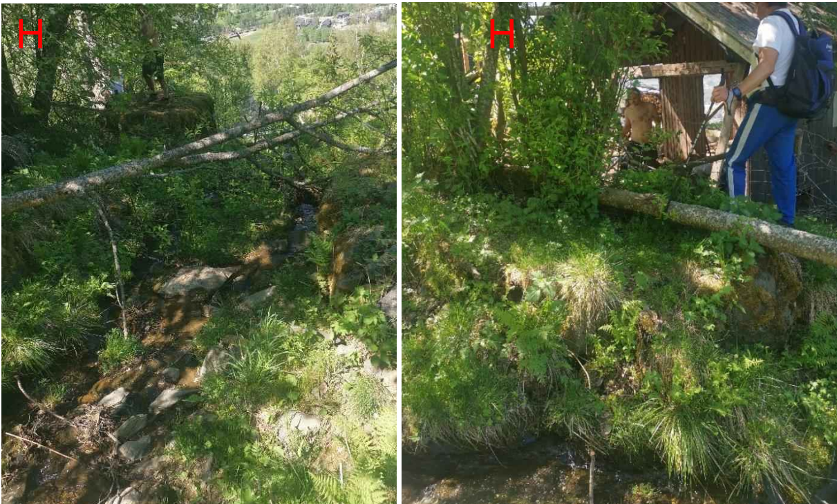
Figur 142: Bilder som viser punkt H på strekket. Bekken går svært nærme bebyggelsen, og grunneier kunne opplyse om at vann tok på avveie mot bebyggelsen i perioder med mye avrenning.
