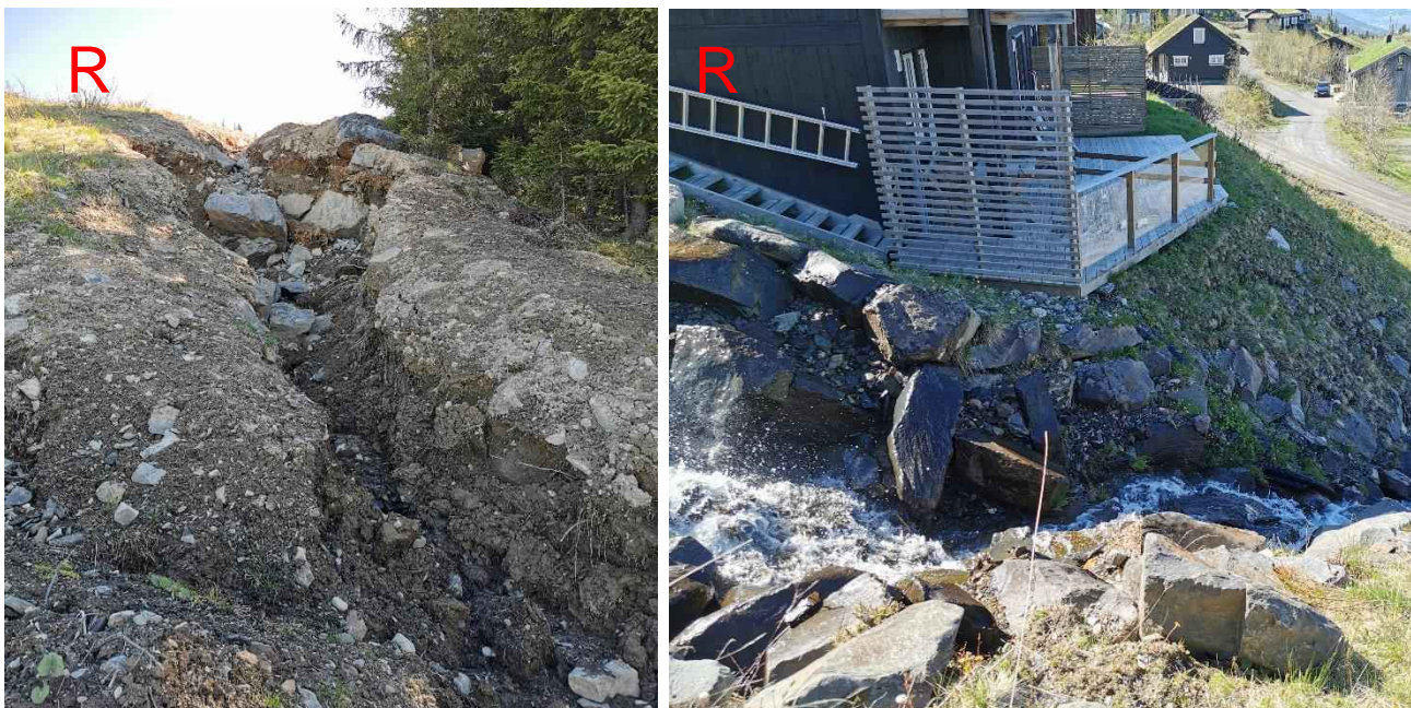
Figur 100: Flomveien langs nordsiden av hyttefeltet ved Kaldsvekroken (R). I flomsituasjoner/snøsmelting kan det komme en del vann i flomveien fra nord-øst, selv om denne var tørr under befarig (t.v.). Litt lenger nedstrøms kommer det ut et silder og en mindre lukking hvor det var en del vannføring. Bekkeløpet videre går tett på hyttebebyggelsen (t.h.), og erosjonssikringen er stedvis mangelfull. Området var preget av mye erosjon.
