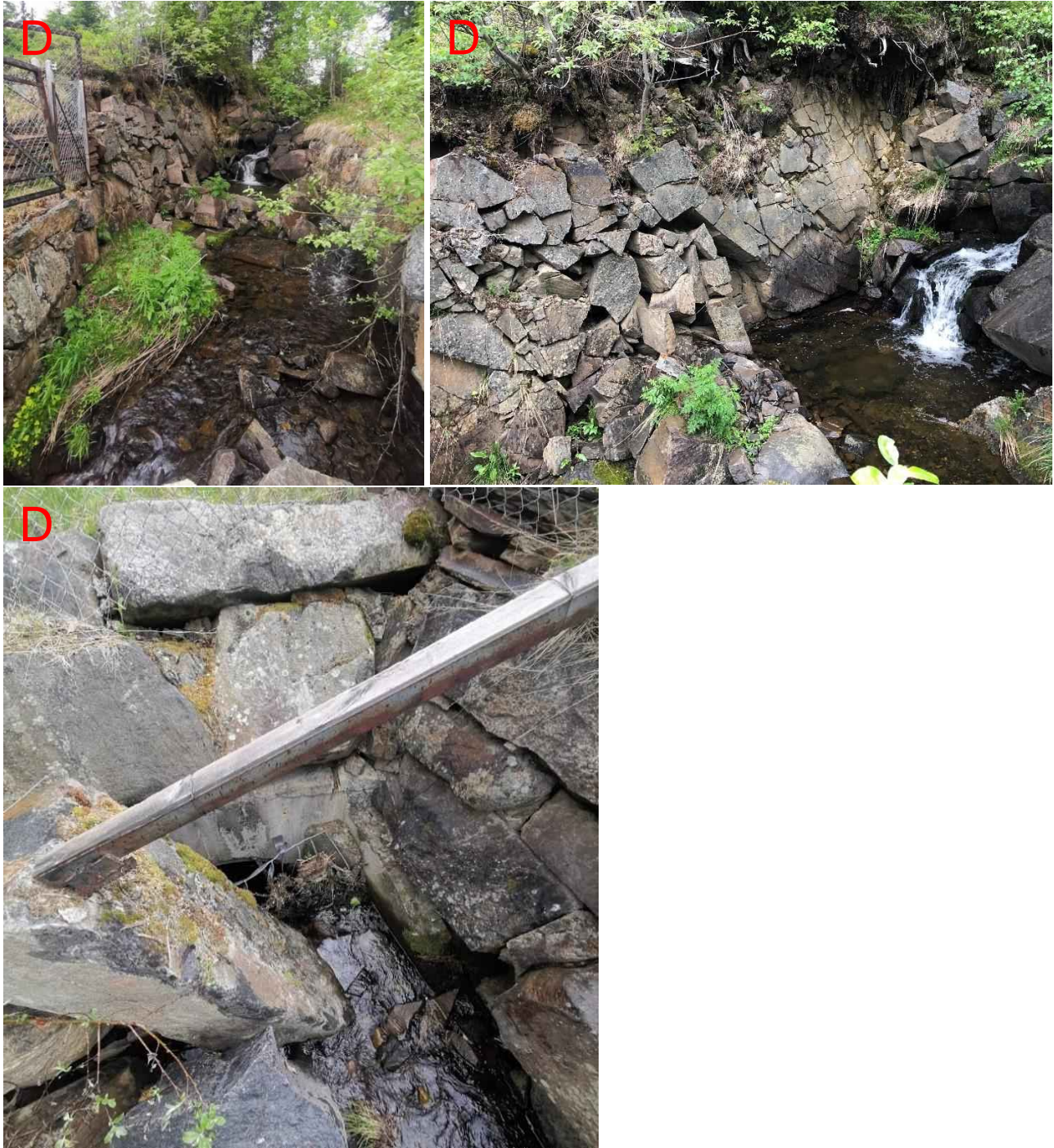
Figur 216: Bekken er lukket under hytten på eiendommen Sæterråket 16. De to øverste bildene viser bekkefarene noen få meter ovenfor innløpet, med bl.a. oppsprukket berg og løsmasser som kan eroderes og fraktes videre nedover i flomsituasjoner. Det nederste bildet viser innløpet til bekken. Det kan skimtes en rist foran innløpet, samt at det har rast ut og erodert, og det er i ferd med det går helt tett. Da er det fare for skader på bebyggelsen, som ligger oppå bekkelukkingen. Det var umulig å måle størrelsen på røret til bekkelukkingen i innløpet, men ved utløpet var den 1000 mm. Ifølge hytteeier har det skjedd flomskader her tidligere. Dette er et svært sårbart område hvor det bør gjøres strakstiltak.
