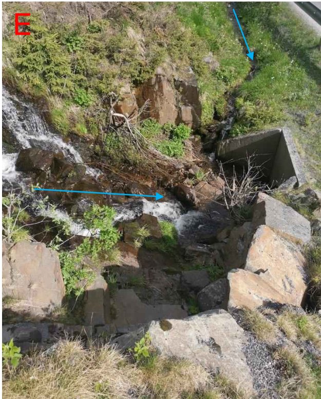
Figur 218: Stikkrenna (1000 mm) gjennom Hundersætervegen ved ca. 812 moh. er sårbart og kritisk, fordi vannet kan renne på avveie ned gjennom hytteområdene ved Bjørgegruva og til Bjørgesætra, samt videre ned til den nordlige delen av Bjørgebekken, dersom stikkrenna går full eller tettes. Det er veldig mange store steiner og mye løsmasser i bekkeløpet oppstrøms som kan bli ført ned med bekken i en flomsituasjon og tette stikkrenna. Det er bygd opp en slags flomvoll av steinblokker på den nordlige siden av inntaket til stikkrenna, vist til venstre i bildet til høyre, noe som kan tyde på at det har vært vann på avveie her før.
