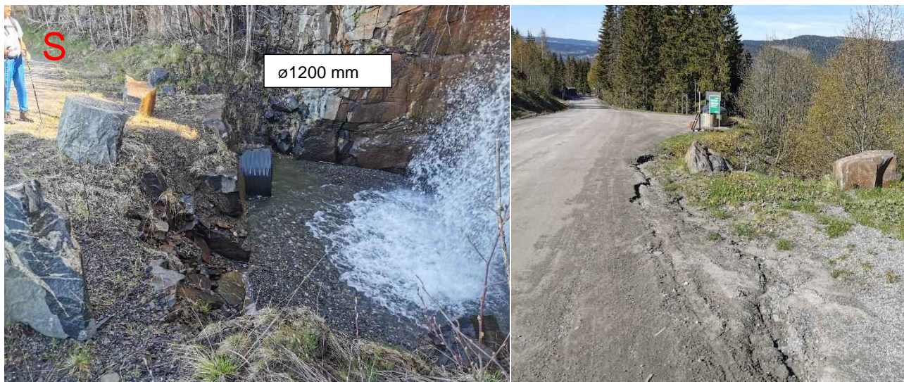
Figur 105: Innløp av kulvert i punkt S. Foran innløpet er det en liten dam. Denne må tømmes jevnlig for sedimenter for å unngå redusert kapasitet i innløpet (t.v.). På Mosætervegen er det erosjonsskader langs nord-vestre side, som bekrefter at det kommer ned en flomvei fra høyere opp sørover langs Mosætervegen. Dette kan f.eks. være smeltevann fra alpinbakken.
