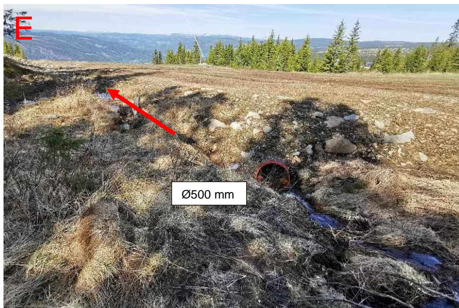
Figur 86: Innløp på stikkrenne i punkt E, hvor flomveien videre er vist med rød pil.
