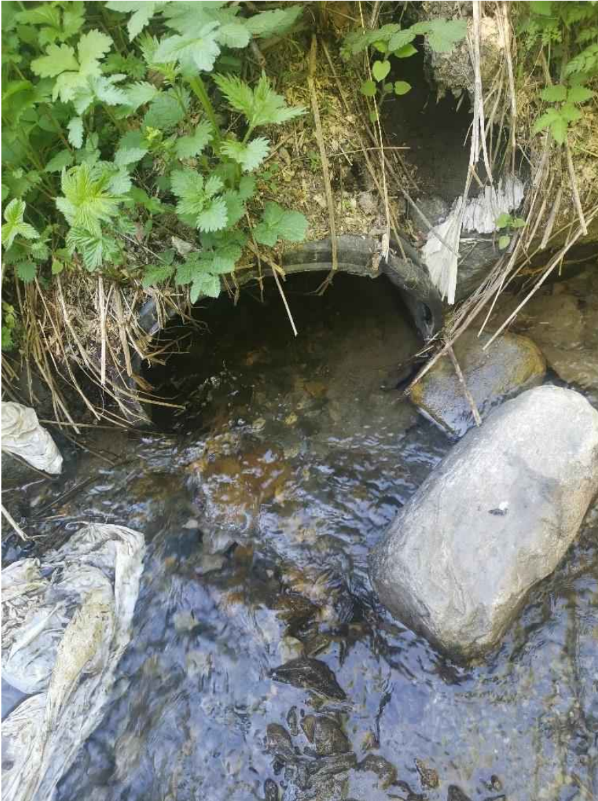
Figur 144: Innløpet til stikkrenna (400 mm) rett nedstrøms punkt I. Stikkrenna er moden for rensk. Antakeligvis vil vannet renne tilbake i bekken igjen like nedstrøms dersom stikkrenna går full eller tettes.
