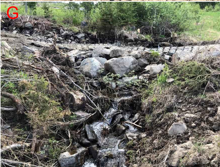
Figur 191: Punkt G, der bekken er rasert av skiløypa/anleggsvegen for utbygging i området. Stikkrenna (800 mm) gjennom turveien noen få meter nedstrøms har halve innløpet dekket med sedimenter som vist på bildet nederst til høyre. Antakeligvis vil vannet renne over stikkrenna og tilbake i bekken i en flomsituasjon i dette punktet, men slike ødeleggelser av bekken kan føre til problemer på en lang strekning nedstrøms.
