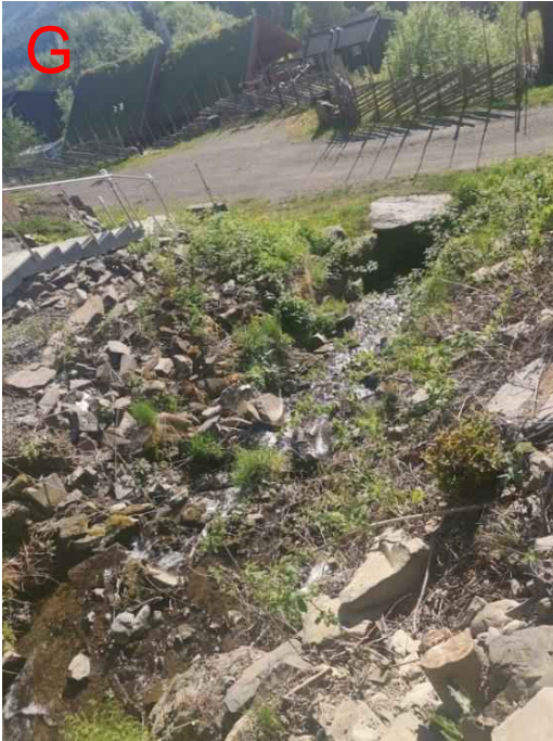
Figur 170: Punkt G, hvor stikkrenna (800 mm) fører Solbergbekken gjennom adkomstveg til boliger. Vann kan ta på avveie over vegen og gå mot bebyggelse nedstrøms. Det er en god del sedimenter i bekkeløpet oppstrøms og i innløpet til stikkrenna, som dermed får sterkt redusert kapasitet.
