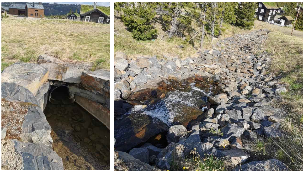
Figur 67: Viser eksempler på hvordan Dalanbekken er ført gjennom hyttefeltet ved J, K og L.
