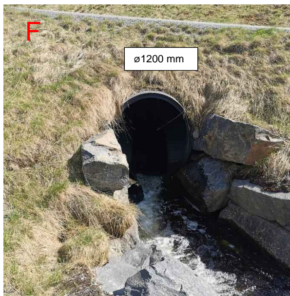
Figur 52: Til venstre ses utløpet av stikkrenne gjennom Storslåvegen. Vegens helning vil lede vannet mot høyre i bildet ved kapasitetsproblemer (mot Dalanbekken). Til høyre vises erosjonsskadene nedstrøms punkt F.
