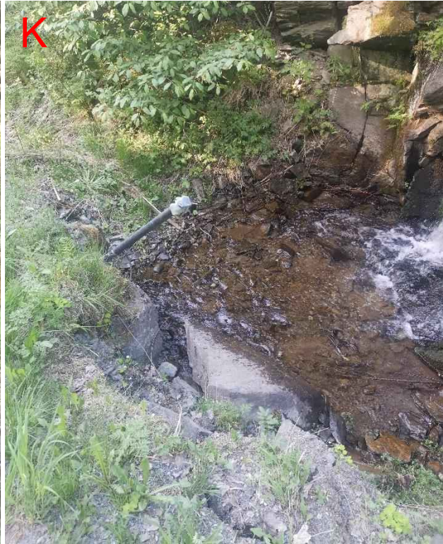
Figur 175: Punkt K, hvor stikkrenna (800 mm) tar Solbergbekken gjennom Måkrudgutua. Det er en del sedimenter i innløpet som gjør at stikkrenna har litt redusert kapasitet. Det er erosjonsspor på nordsiden av stikkrenna, hvor det er fare for at vann tar på avveie dersom stikkrenna går full eller tettes.
