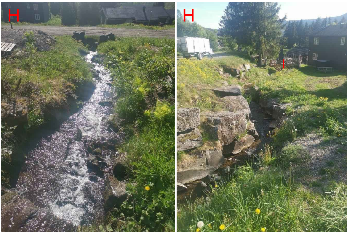
Figur 172: Bildet til venstre viser bekkefarett oppstrøms og innløpet til stikkrenna (1000 mm) i punkt H, som fører Solbergbekken gjennom adkomstvegen til boliger i området. Bildet til høyre viser bekkefaret mellom punkt H og punkt I. Både før og etter stikkrenna er bekken kanalisert, og har unaturlig lite plass å bre seg på. Dette er et sårbart punkt med tanke på bebyggelsen i nærheten dersom stikkrenna går full eller tettes. I bildet til høyre skimtes starten på en bekkelukking ved skigarden (1000 mm, punkt I, markert med bokstav i bildet) som skimtes et stykke nedstrøms stikkrenna i punkt H.
