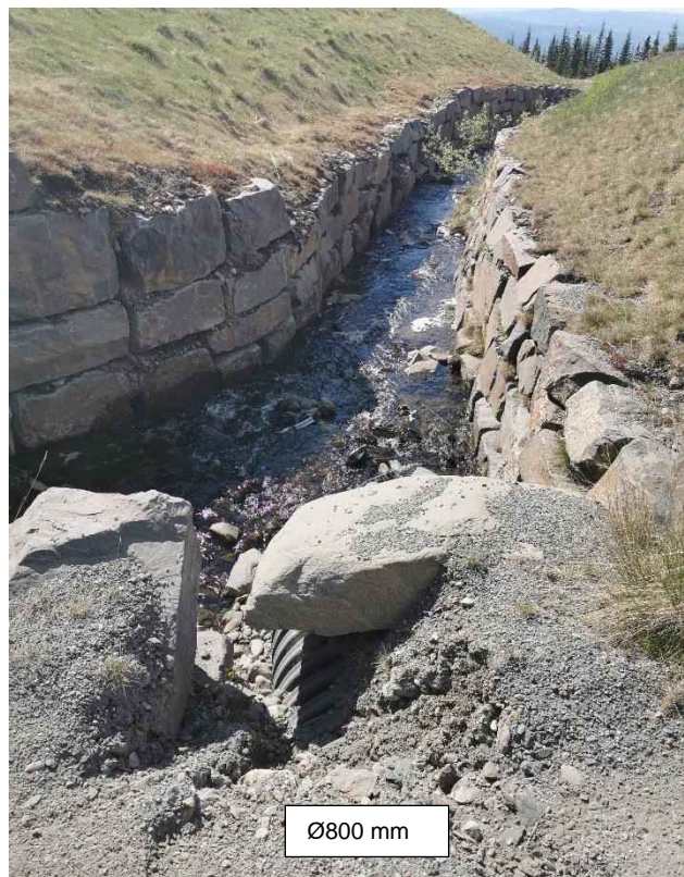
Figur 51: Søre Slåbekken er lagt i en renne under ei bru i nordenden av strekning E (t.v.). Det er store erosjonsskader ved enden av renna hvor traseen har en 90 graders sving og en stikkrenne fra øst også har utløp. Det er fare for utrasing av større blokker som kan begrense kapasiteten i bekken. Finmasser langs vegen er også i ferd med å vaskes ut.
