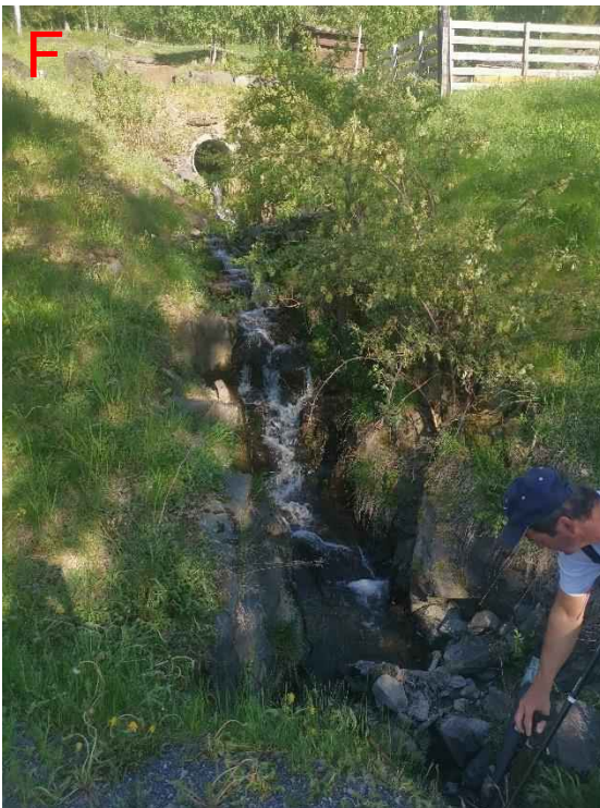
Figur 169: Bildet til venstre viser utløpet til stikkrenna (800 mm) i punkt E, og så vidt vises innløpet til stikkrenna (800 mm) i punkt F nederst i bildet. Bildet til høyre viser utløpet til stikkrenna i punkt F og bekketraseen like nedstrøms.
