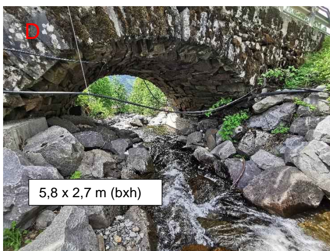
Figur 17: Bruer i punkt D (t.v.) og E. Bru D har bl.a. kabler/ledninger hengende foran og gjennom brua. Dette gir økt fare for at f.eks. trær og kvist setter seg fast og begrenser kapasitet i en flomsituasjon. Bilde av bru E viser spesielt høy fare for gjentetting, da flere store steiner blokkerer deler av lysåpningen.
