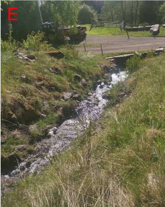
Figur 168: Bildene viser innløpet til stikkrenna (800 mm) i punkt E. Her er det fare for at vann tar på avveie nordover mot bebyggelse før det drenerer mot bekken igjen.
