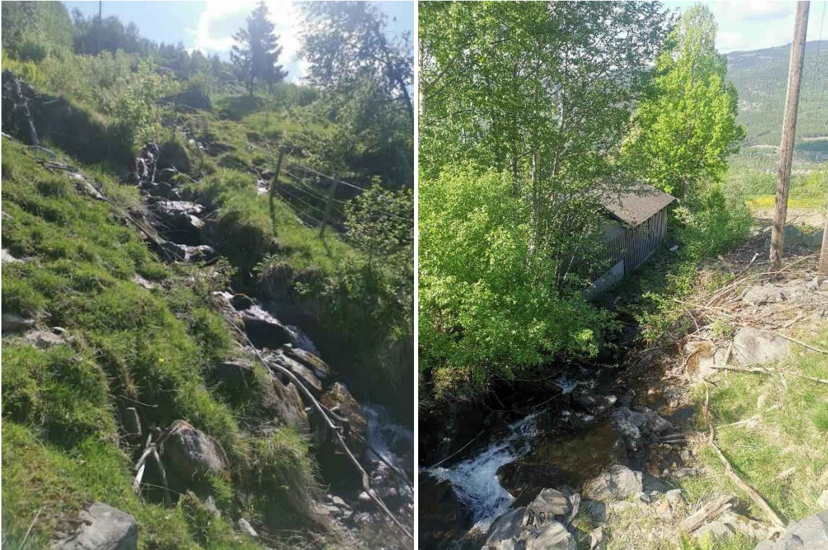
Figur 196: Bildet til venstre viser Stubberudbekken oppstrøms Sørbygdsvegen, hvor det er mye vannsig og vann i grunnen. Vannet sprer seg i ura, og strekket er veldig erosjonsutsatt. Denne dagen var det fire strenger det rant vann i, som samlet seg like oppstrøms Sørbygdsvegen. Bildet til høyre viser at like oppstrøms Sørbygdsvegen, hvor bekken har samlet seg igjen, går bekken veldig nærme bebyggelse. Det kommer et rør (300 mm) hvor det renner jevnt med vann inn i bekken fra nord.
