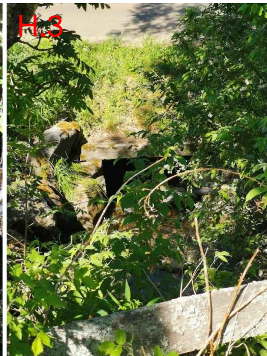
Figur 247: I punkt H er det tre sikkrenner etter hverandre som alle er sårbare med tanke på gjentetting og at vann på avveie kan gjøre skade nedstrøms. H.1 er en 1200 mm stikkrenne med en 300 mm stikkrenne som nødoverløp. H.2 er en 1000 mm stikkrenne med en 300 mm stikkrenne som nødoverløp. H.3 er en kulvert på ca. 1200x800 mm.
