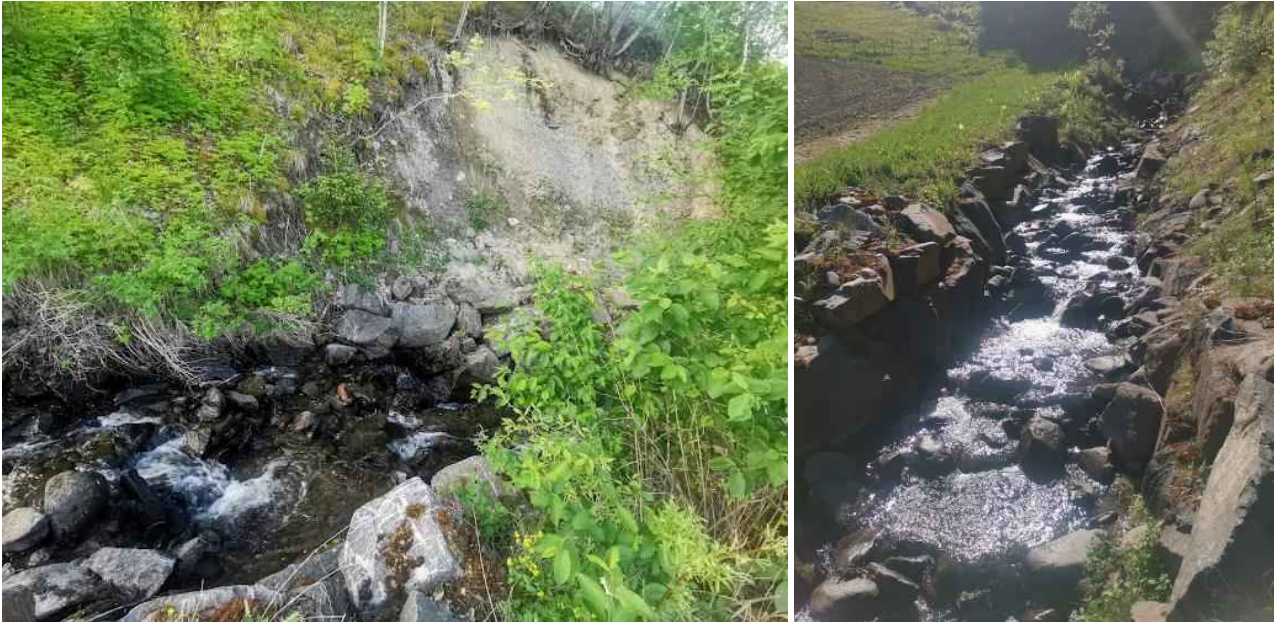
Figur 200: Bildet til venstre viser en skråning som har rast ut i bekken like oppstrøms Måkrud/punkt K. Erosjon i skråningene kan bla. skyldes at bekken har fått større fart. Stikkrenner og bekkeløp nedstrøms kan bli gjentettet av massene. Strekket vist til høyre er et strekke av bekken som antakelig er pigget ut og rettet ut, noe som bidrar til å gi bekken større fart.
