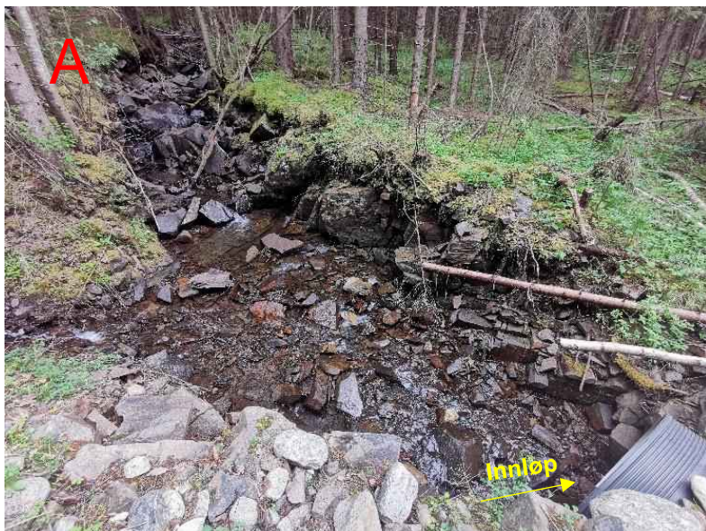
Figur 262: Oppstrøms innløpet til den øverste av stikkrennen som krysser Tyttebærskogen (punkt A). Potensialet for massetransport er stort i hele bekken og særlig vil massene nærmest innløpene kunne tette igjen stikkrennene ved neste flom.
