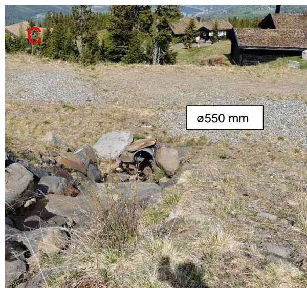
Figur 74: Figuren til venstre viser utløpet av stikkrenne i punkt A. Kapasiteten i bekkeløpet er liten i område B, og faren for vann på avveie øker mye dersom bekkeløpet delvis blokkeres av gjenstander slik som på bildet. Til høyre vises innløpet av stikkrenne i punkt C. Kapasiteten her er også liten, og innløpet er delvis gjentettet av steiner. Vann på avveie kan potensielt skade bebyggelse, selv om sannsynligheten for dette er liten.
