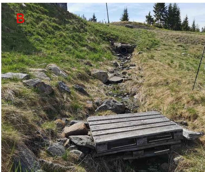
Figur 74: Figuren til venstre viser utløpet av stikkrenne i punkt A. Kapasiteten i bekkeløpet er liten i område B, og faren for vann på avveie øker mye dersom bekkeløpet delvis blokkeres av gjenstander slik som på bildet. Til høyre vises innløpet av stikkrenne i punkt C. Kapasiteten her er også liten, og innløpet er delvis gjentettet av steiner. Vann på avveie kan potensielt skade bebyggelse, selv om sannsynligheten for dette er liten.
