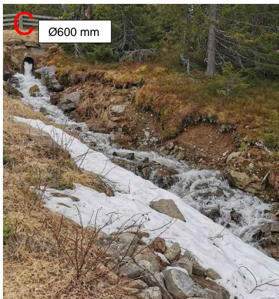
Figur 85: Utløp av stikkrenne i oppstrøms ende av C, og erosjonsskader i bekkeløpet nedstrøms. Innløp ved D (t.h.) og angivelse av retning på flomvei videre dersom denne går full.
