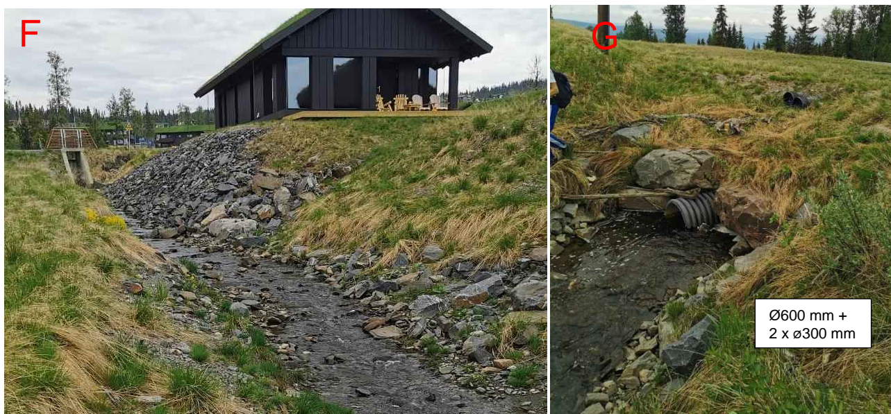
Figur 41: Nedstrøms FLS4 (F) er det bygget ei hytte nært inntil bekken på en fylling som vil være erosjonsutsatt ved flom, og som tydelig har redusert tverrsnittet av bekkeløpet. Til høyre (G) er innløpet av stikkrenna gjennom rulleskiløypa. Denne var nesten dykket under befaring, da vannføringen var liten. Kapasiteten er svært begrenset, og vann kan komme på avveie selv ved mindre og hyppige flommer.
