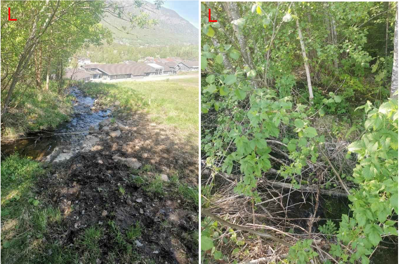
Figur 149: Punkt L. Til venstre vises et sårbart punkt hvor det er potensiale for at vannet tar på avveie mot Hafjell booking, som er bygningen man ser lenger nedstrøms. Til høyre er et bilde fra like nedstrøms bildet til venstre, hvor man ser enda et eksempel på at det er masse hogstavfall i bekkeløpet.
