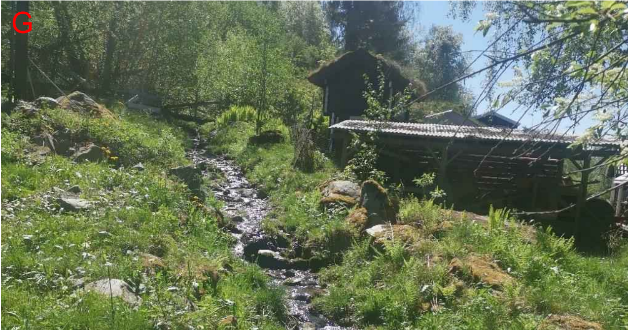
Figur 141: Punkt G på strekket. Like oppstrøms den delen av bekken som vises på bildet, tar bekken en 90° sving hvor vann lett kan ta på avveie mot bebyggelsen i flomsituasjoner.
