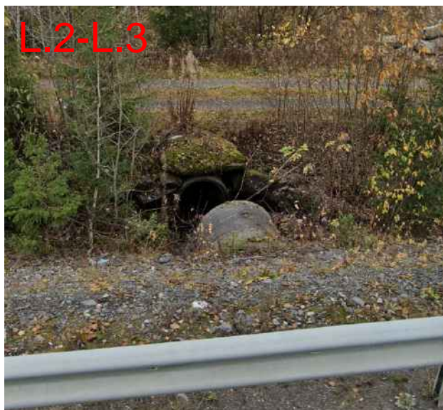
Figur 205: Bildet til venstre er hentet fra Google Street View (tatt oktober 2019) og viser «overgangen» mellom stikkrenne L.2 (1000 mm) og L.3 (1000 mm, erosjonsskadet). Bildet til høyre viser utløpet til stikkrenne L.2.
