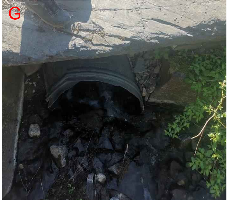
Figur 170: Punkt G, hvor stikkrenna (800 mm) fører Solbergbekken gjennom adkomstveg til boliger. Vann kan ta på avveie over vegen og gå mot bebyggelse nedstrøms. Det er en god del sedimenter i bekkeløpet oppstrøms og i innløpet til stikkrenna, som dermed får sterkt redusert kapasitet.
