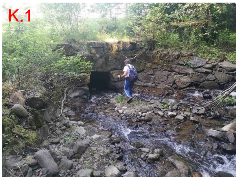
Figur 230: Inn- og utløpene som ble observert på befaringen som fører Bjørgebekken gjennom Hundervegen og E6. Vann kan ta på avveie sørover dersom kulvertene (1200x1200 mm og 1200 mm) går full eller tettes. Ifølge vegkart.no er det flere stikkrenner langs veien som kan ta unna for vann på avveie, men det er vanskelig å vite hvordan de vil tåle ekstra belastning i en flomsituasjon.
