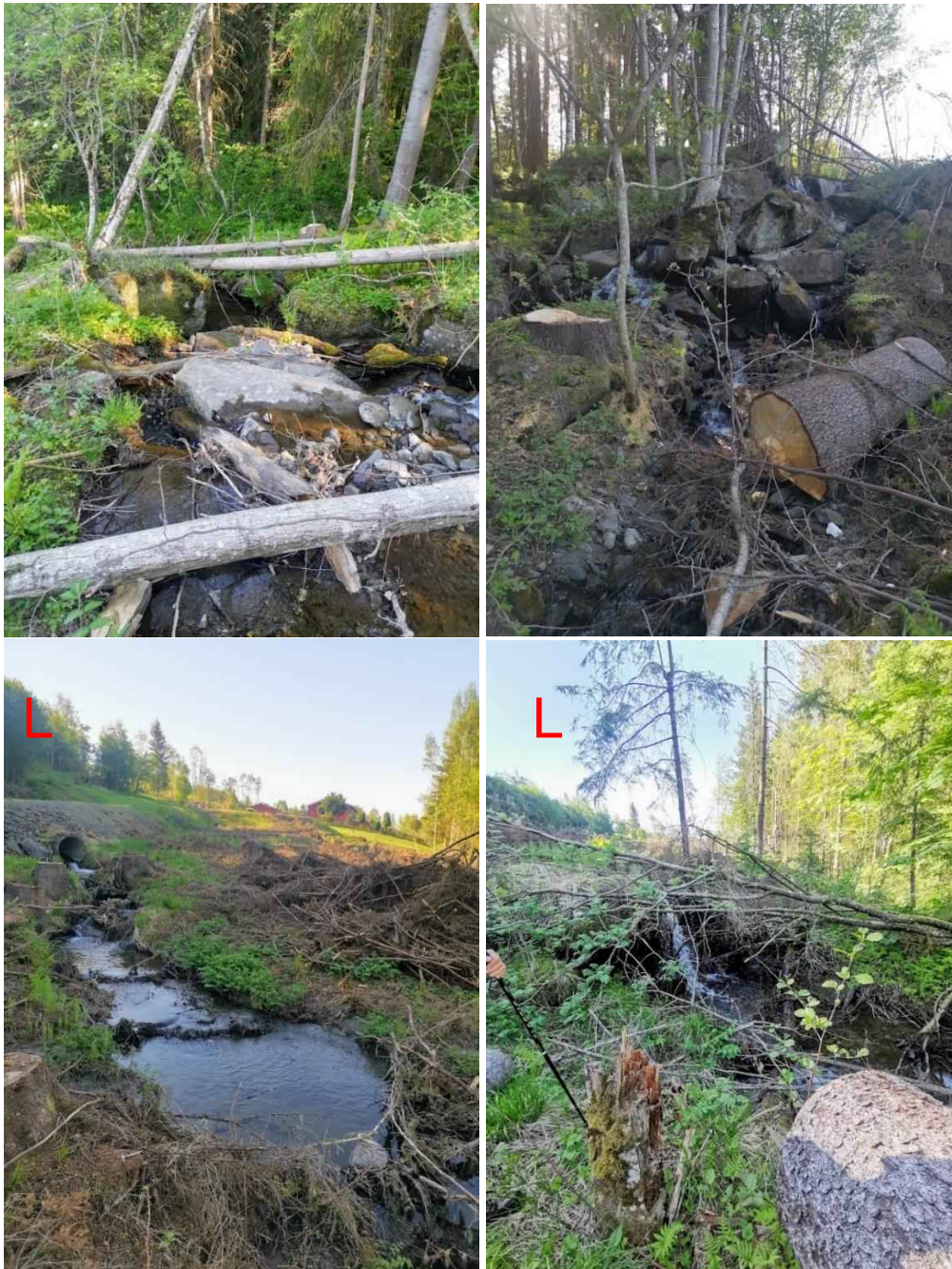
Figur 202: De to øverste bildene viser bekkeløpet mellom «hovedvegen» Måkrudgutua og adkomstvegen til Måkrudgutua 11. De to nederste bildene viser bekkeløpet mellom adkomstvegen til Måkrudgutua 11 «hovedvegen» Måkrudgutua. Dersom stikkrenna (1000 mm) gjennom Måkrudgutua går full eller tettes vil vann antakelig renne over i Solbergbekken, ev. over vegen og ende opp i Stubberubekken igjen. Nedstrøms stikkrenna og mot Hundervegen og E6 er det potensiale for en flomskredbekk. Her er det mye massetransport og litt flatere områder, og hvis vannet demmes opp er det potensiale for at det kan utløse et flomskred. Det er viktig infrastruktur nedstrøms, og dermed er dette vurdert som et svært sårbart område. Det er mye tegn til erosjon, og store krefter i sving fra vannet da det «koker» i bekkeløpet. Ved en flom kan sikkerheten til E6 være utsatt.
