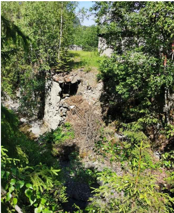
Figur 256: Mellom kryssing av Hundervegen og E6 (A-B) har bekken svært bratte sider, hvor det har vært mye erosjon og hvor det ligger mye løsmasser som stein og hageavfall. Restene etter en gammel betongmur er også i ferd med å rase ut i bekken.
