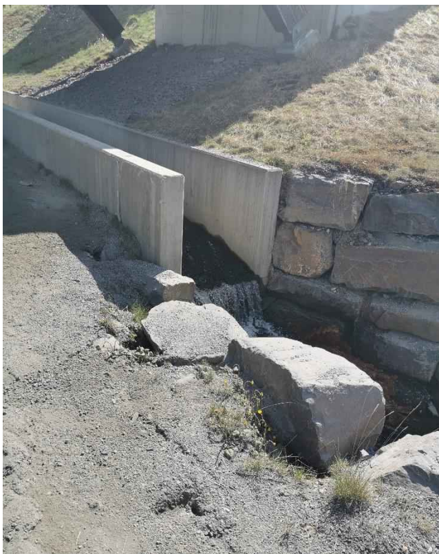
Figur 51: Søre Slåbekken er lagt i en renne under ei bru i nordenden av strekning E (t.v.). Det er store erosjonsskader ved enden av renna hvor traseen har en 90 graders sving og en stikkrenne fra øst også har utløp. Det er fare for utrasing av større blokker som kan begrense kapasiteten i bekken. Finmasser langs vegen er også i ferd med å vaskes ut.
