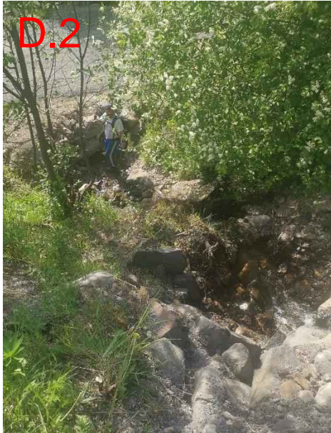
Figur 165: Bildene viser strekket ned til og innløpet til stikkrenna (600 mm) som tar Solbergbekken under adkomstvegen til Sørbygdsvegen 332. Det er laget en voll rundt innløpet. Her er det stor fare for erosjon, gjentetting av innløp og vann på avveie.
