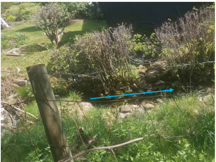
Figur 166: Bildet viser at bekken er lukket (3-400 mm rør), og at det er etablert en grønnsakshage over bekken. Her er bekken kanalisert med et mye trangere bekkeløp enn det som er naturlig. Både lukking og bekkeløp er sårbart og har alt for liten kapasitet.
