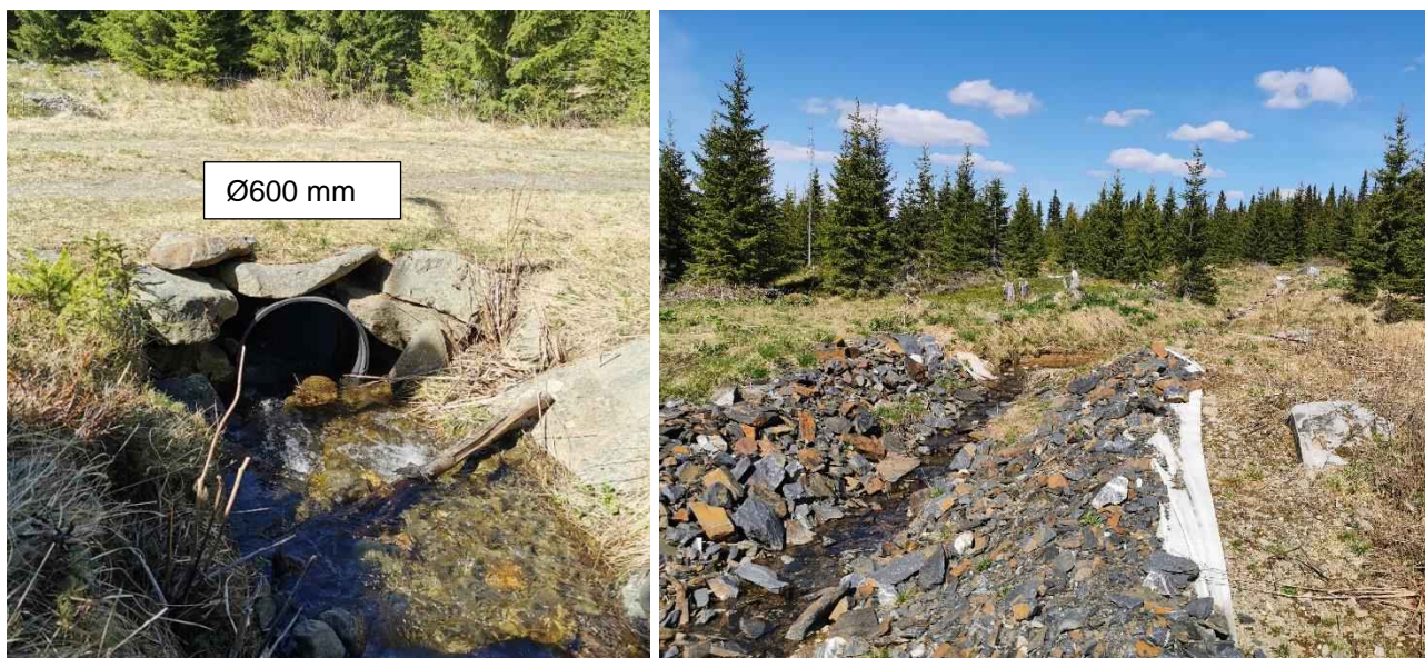
Figur 64: Til venstre: Innløpet av 600 mm stikkrenne oppstrøms den antatte bekkeomleggingen. Til høyre viser nytt bekkeløp med røyset stein. Tilrenningen fra oppstrøms områder er noe diffus og spredd over en lengre strekning.
