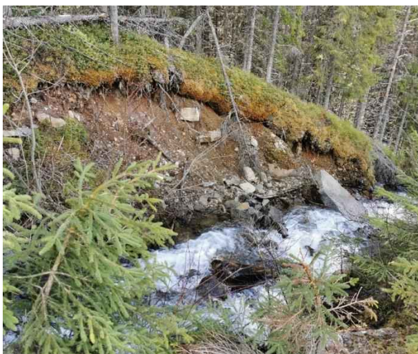
Figur 116: Eksempel på erosjonsskader langs bekken (nedstrøms Doldaveien) som medfører mye massetransport.
