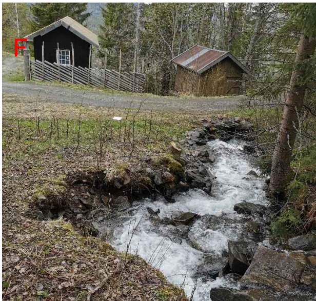
Figur 121: Punkt F (t.v.): Innløpet på stikkrenne ved Mosætervegen 165 sett oppstrøms fra. Stikkrenna er trolig for liten og det er mye erosjon og sedimenter/sedimenttransport oppstrøms som kan tette den igjen/ redusere kapasiteten. Det er også tegn til erosjonsskader ut av bekkeløpet. Det er fare for bygningene nedstrøms i begge tilfeller. Punkt G (t.h.): Innløp på stikkrenne som ved gjentetting/ redusere kapasiteten kan medføre flomfare for flere bygninger nedstrøms. Det er en del erosjonsskader rundt innløpet, og røret gjennom stikkrenna kan øke faren for gjentetting.
