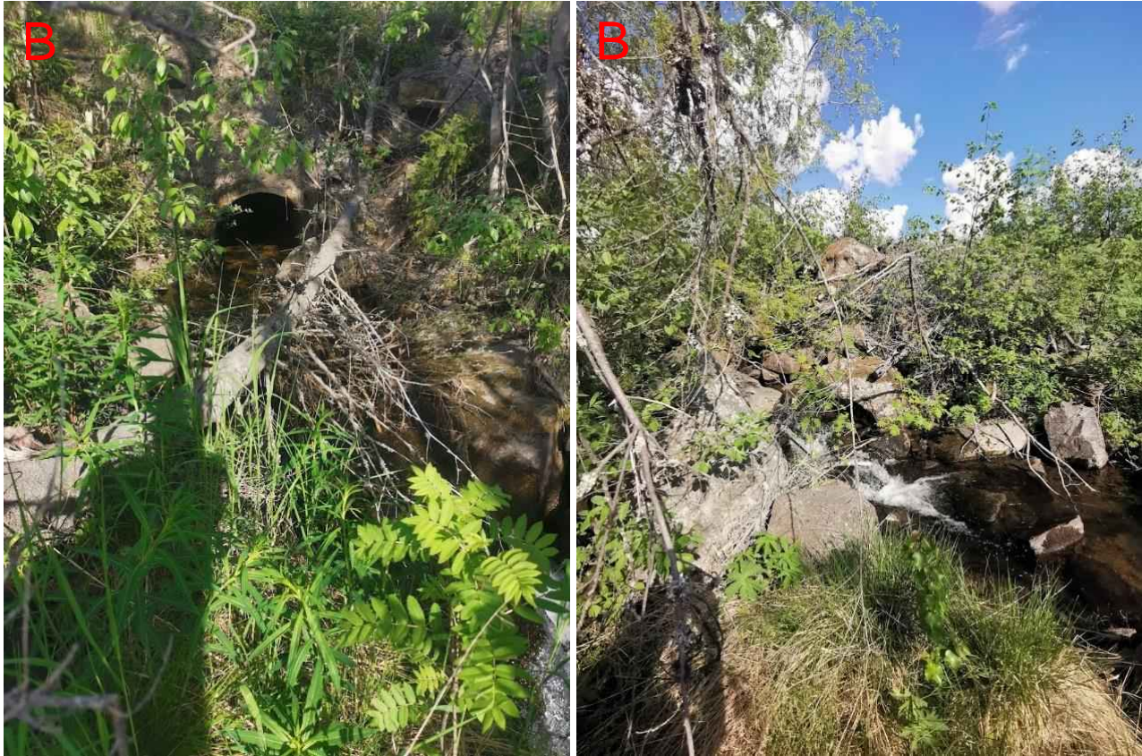
Figur 239: Utløpet til stikkrenna (1000 mm) vises i bildet til venstre. Bildet til høyre viser bekkeløpet noen meter lengre ned. Det ligger mye trær og stein i bekkeløpet som kan føres videre nedover i en flomsituasjon.
