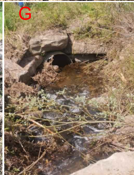
Figur 191: Punkt G, der bekken er rasert av skiløypa/anleggsvegen for utbygging i området. Stikkrenna (800 mm) gjennom turveien noen få meter nedstrøms har halve innløpet dekket med sedimenter som vist på bildet nederst til høyre. Antakeligvis vil vannet renne over stikkrenna og tilbake i bekken i en flomsituasjon i dette punktet, men slike ødeleggelser av bekken kan føre til problemer på en lang strekning nedstrøms.
