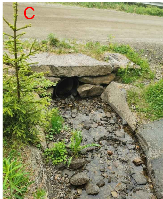
Figur 31: Bilder som viser sårbare punkter i befart del av Lisæterbekken. Mye massetransport og erosjonsskader.
