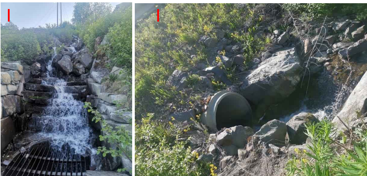
Figur 197: Inn- og utløpet til stikkrenna (1000 mm) i punkt I igjennom Sørbygdsvegen.
