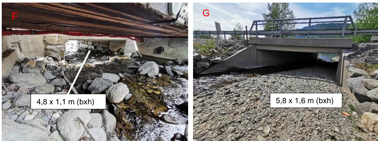
Figur 19: Bruer i punkt F (t.v.) og G (bru for E6). Det er tydelig at sedimenter opplagres over tid, og at bruene er utsatt for kapasitetsproblemer. Det er viktig med jevnlig vedlikehold i form av rensk for å unngå flomskader og vann på avveie.
