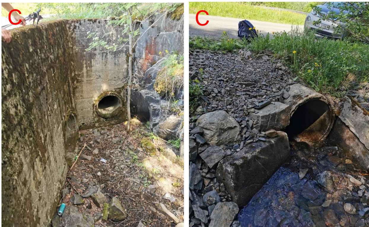
Figur 265: Det er to stikkrenner gjennom Hundervegen for Kvesa (C), hvorav den lengst sør (t.v.) ser ut til å primært være et flomløp, mens løpet langt nord (t.h.) er dreneringsvei i normalsituasjon. Dersom stikkrennene ikke har tilstrekkelig kapasitet vil vann renne utover et større område på østsiden av Hundervegen hvor det gjør lite skade.
