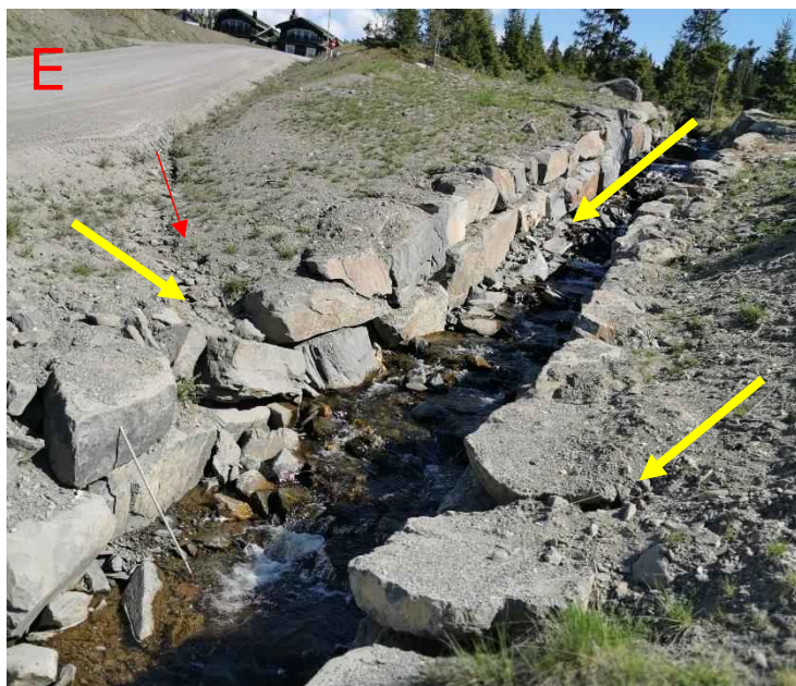
Figur 50: Vann har gravd ut løsmasser mellom større steiner (se gule piler) som er brukt til kanalisering av bekken. Det kan f.eks. komme av mangelfull utførelse av kanalisering, høyere strømningshastighet enn det kanalen er dimensjonert for, og tidvis stor avrenning fra den langsgående vegen og sideområder. Bildet til høyre viser at bekken har lite plass å boltre seg på ved kapasitetsproblemer i kanalen.
