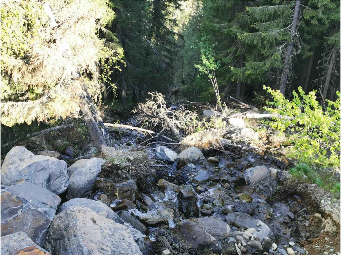
Figur 55: Utløpet av den siste stikkrenna til Dalanbekken før utløp i Mosåa. Stikkrenna går gjennom adkomstvegen til et anleggsområde fra Mosætervegen. Strekningen nedstrøms er ikke befart, pga. høy bratthet, men det ble observert på en strekning på ca. 50 meter nedstrøms at det var betydelige erosjonsskader og stort potensiale for massetransport. Mye av skadene er trolig fra en flom i 2014, men en så tydelige spor etter ny erosjon og massetransport.
