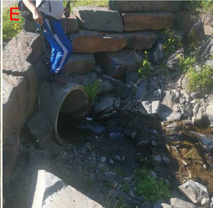
Figur 168: Bildene viser innløpet til stikkrenna (800 mm) i punkt E. Her er det fare for at vann tar på avveie nordover mot bebyggelse før det drenerer mot bekken igjen.
