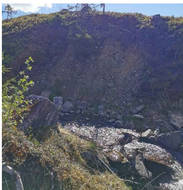
Figur 52: Til venstre ses utløpet av stikkrenne gjennom Storslåvegen. Vegens helning vil lede vannet mot høyre i bildet ved kapasitetsproblemer (mot Dalanbekken). Til høyre vises erosjonsskadene nedstrøms punkt F.
