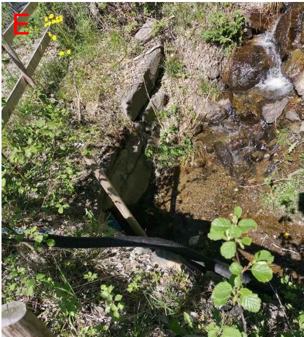
Figur 137: Inn- og utløpet til stikkrenna (550 mm) i punkt E ved Lykkja. Dersom denne stikkrenna tettes eller går full kan vann ta på avveie mot Råbøl, Kaldhol og annen bebyggelse. Det var mye hogstavfall nedstrøms denne stikkrenna.
