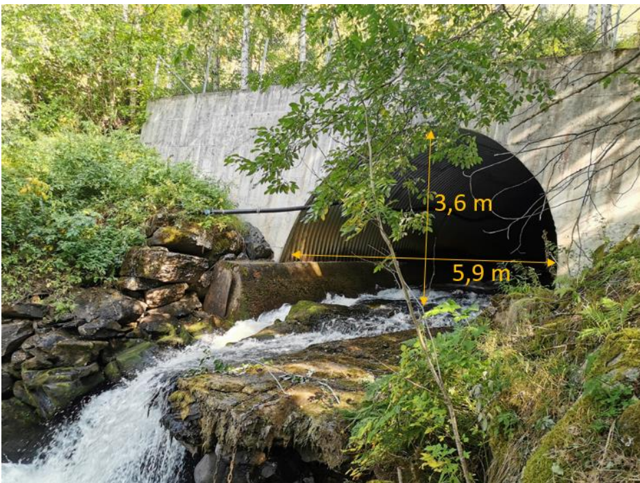
Figur 22: Utløp kulvert Sørbygdsvegen (punkt 10)
