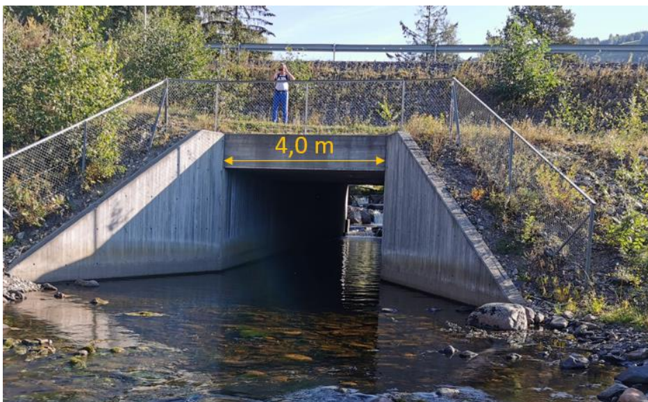
Figur 12: Utløp kulvert under E6 (punkt 1)
