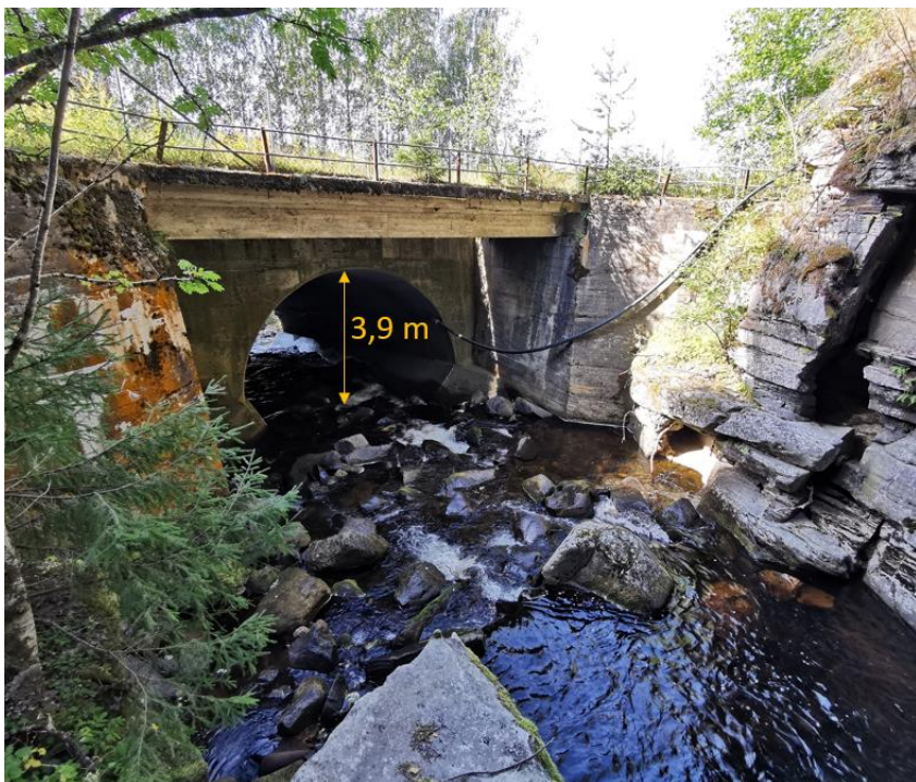
Figur 23: Innløp kulvert Sørbygdsvegen (punkt 10)
