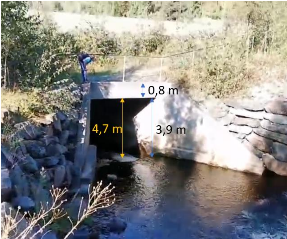
Figur 11: Innløp kulvert under E6 (punkt 1)
